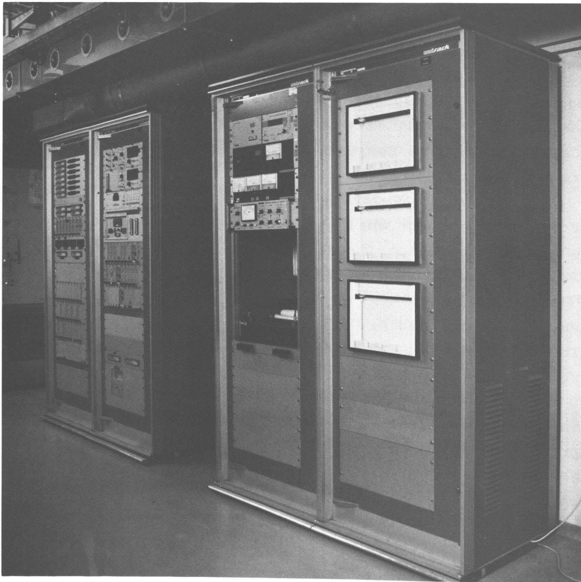
Abb. 3.13: Meßwertanzeige und Meßwertregistrierung für das Tritiumlager (ohne Strahlenschutzeinrichtung)
