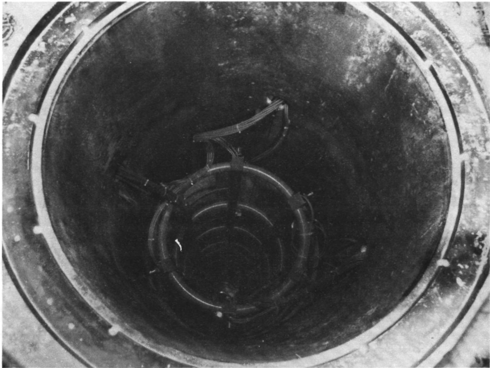
Abb. 2: Blick durch die Bohrlochkopfauskleidung auf das eingebaute Korbgestell in Bohrloch EV 1
