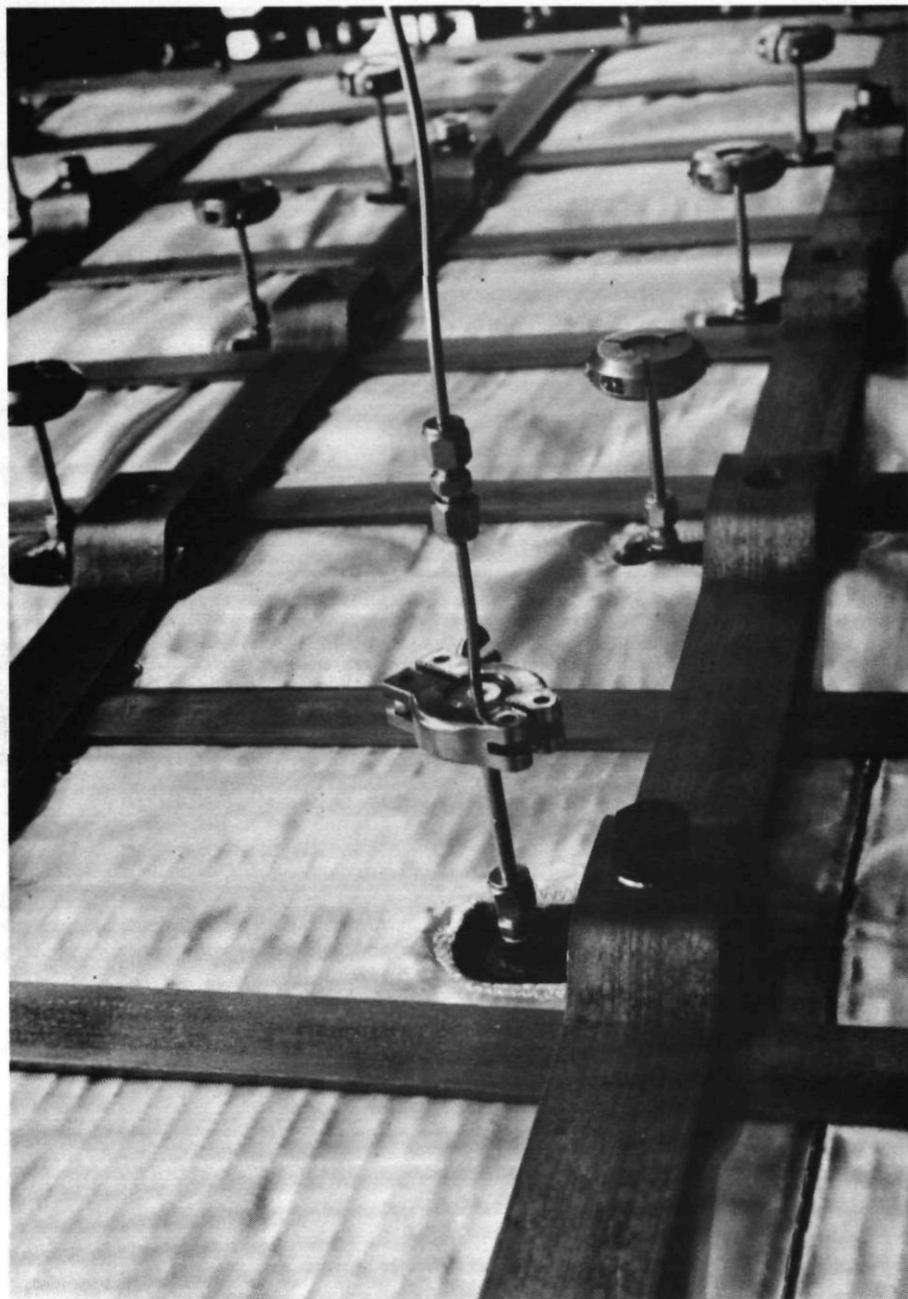
Abb. 11: Anschluß einer Leckageeintrittsbohrung an die Einspeiseleitung
