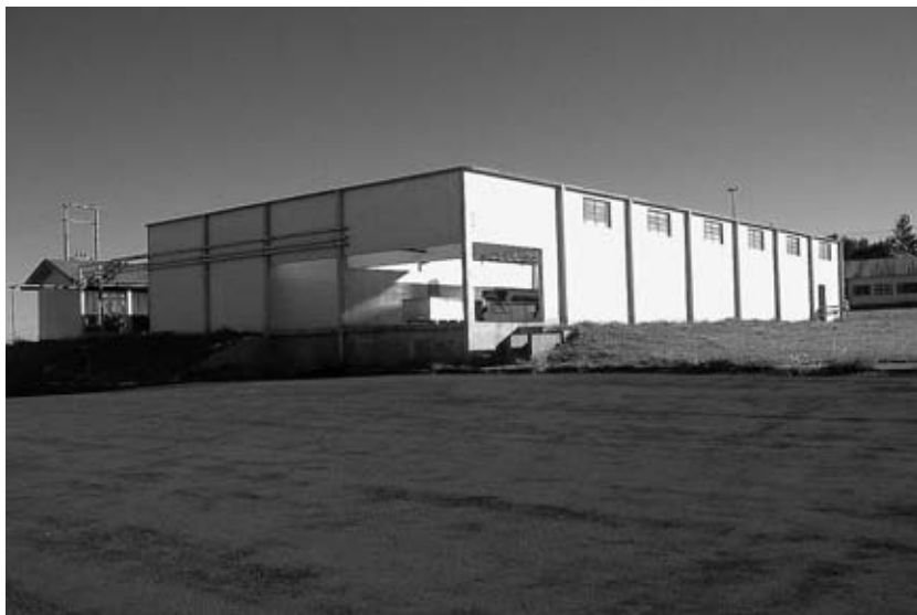
Instalación de COCAMP
