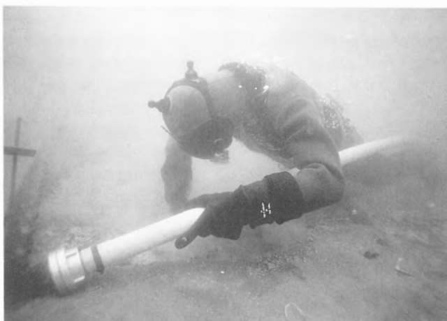
Abb. 11: Latrigen VI-Riedstation. Arbeiten mit dem Strahlrohr.
