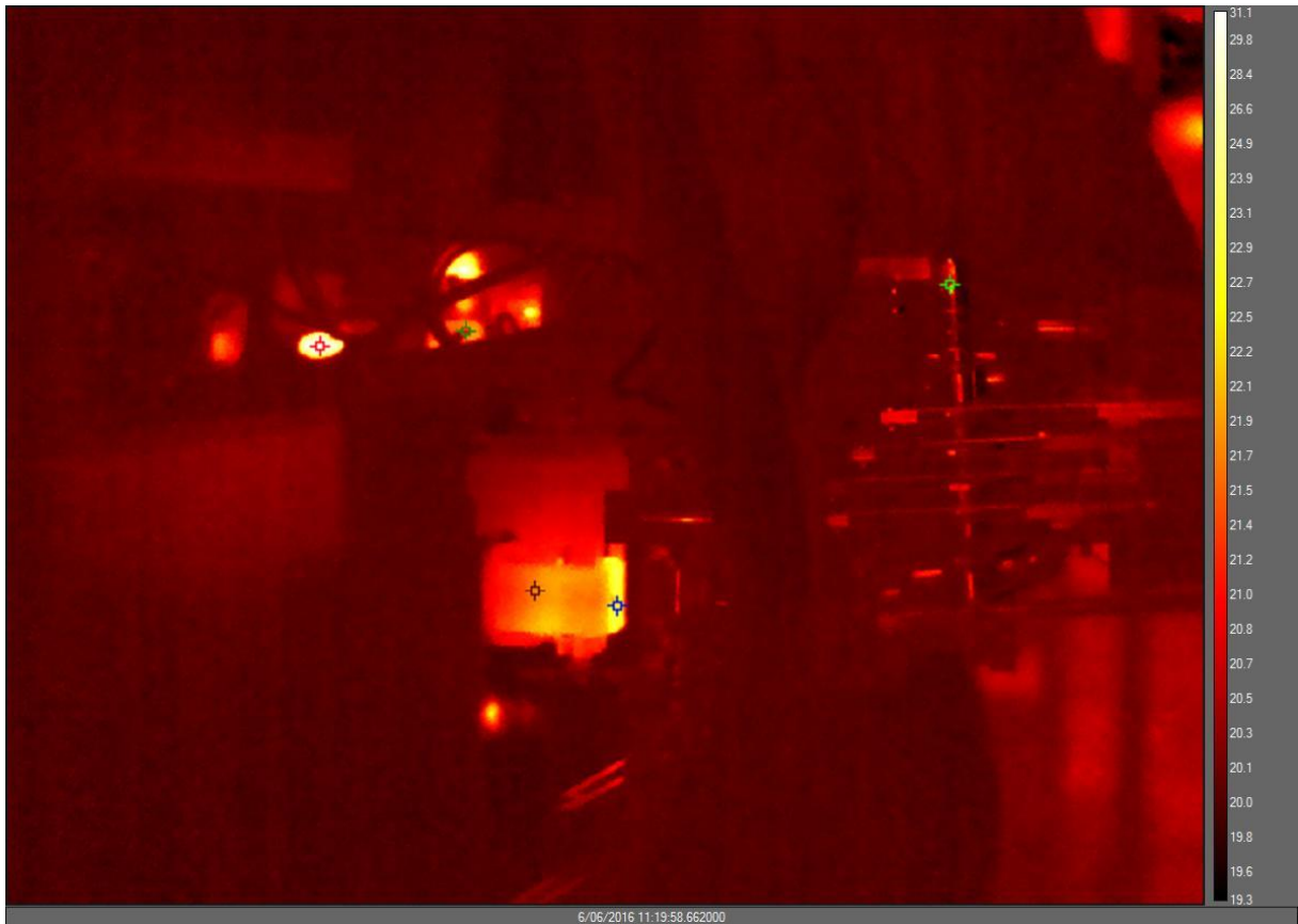
Figure 65 : Vue après mise en marche de l'automate.
