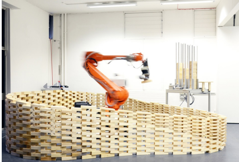
Abbildung 79: Assemblierung der Holzelemente mit automatisierter Materialzufuhr
