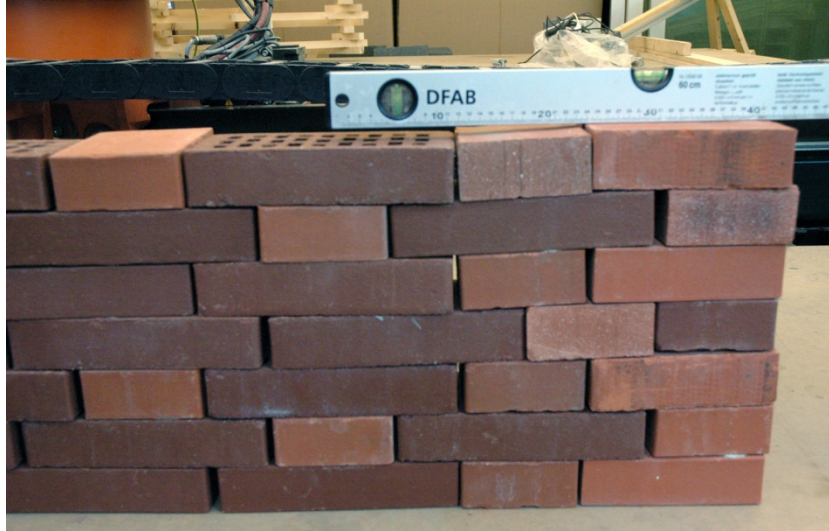
Abbildung 48: Auswirkungen einer Toleranzaddition: Abweichung der Sollmaßhöhe eines mörtellosen Verbundes mit Steinen, die alle dasselbe Nennmaß aufweisen
