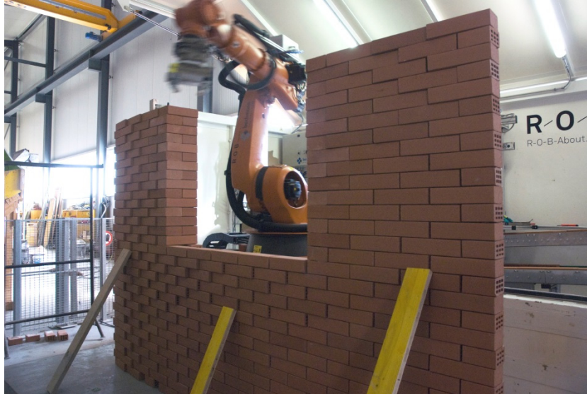
Abbildung 63: Die roboterbasierte Produktion eines Fassadenelementes mit Fensteröffnung
