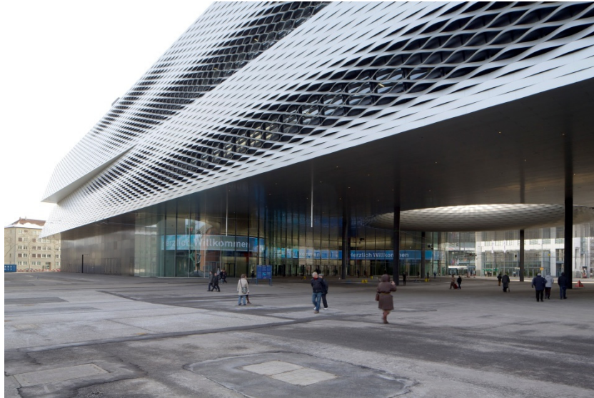
Abbildung 34: Fassade des Neubaus der Messe Basel mit Blick vom Riehenring, Februar 2013
