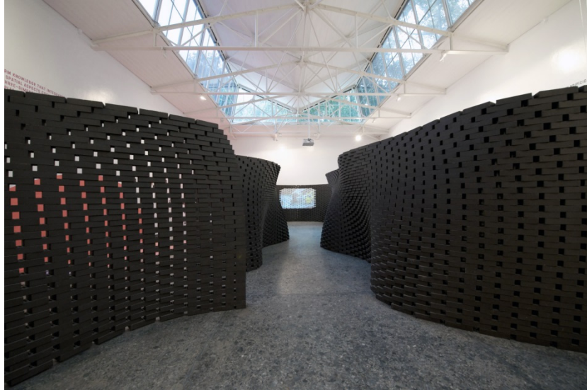
Abbildung 14: Raumbildender Mauerwerksverband der Installation Structural Oscillations, der vor Ort durch die mobile Fabrikationseinheit R-O-B aus Einzelementen assembliert wurde
