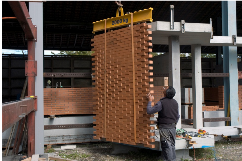
Abbildung 64: Befestigung eines Flexbrick-Elements. Eine Rückverankerung in der Mitte des Bauteils war nicht notwendig
