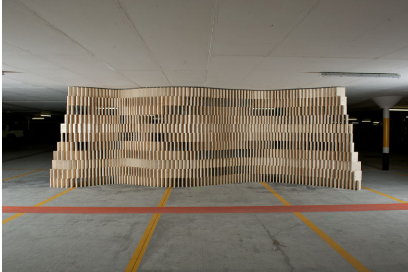
Abbildung 36: In situ fabrizierte Struktur aus 1 000 einzelnen Holzelementen in der Parkgarage der ETH Zürich
