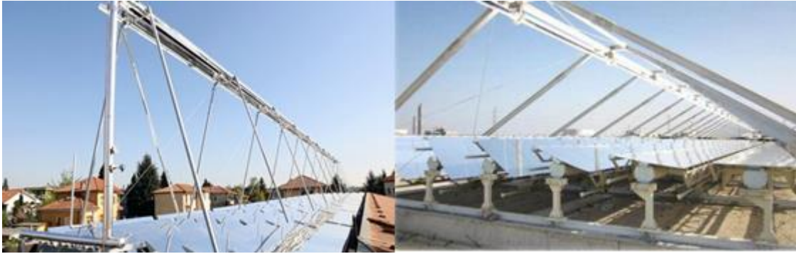
Figura 5.28. Estructura tipo A, colector Ferasolar (izquierda), colector Hitachi Zosen (derecha). Fuente: google imágenes
