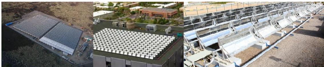
Figura 3.10. Instalaciones termosolares micro-CSP con bloque de potencia situado lateralmente. Fuente: (Sopogy, 2015).
