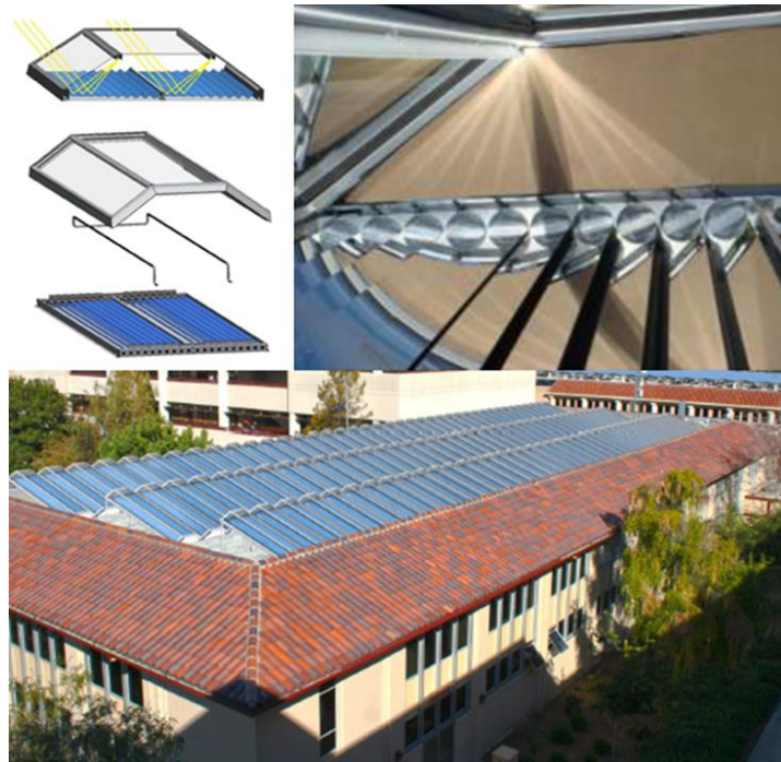
Figura 5.31. Concentrador Fresnel de estructura de cubierta acristalada. Fuente: Chromasun
