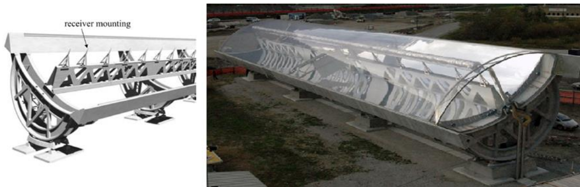
Figura 5.18. Estructura tipo rueda de soporte (derecha) y fotografía de un módulo CCP de Airlight Energy. Fuente: Airlight Energy
