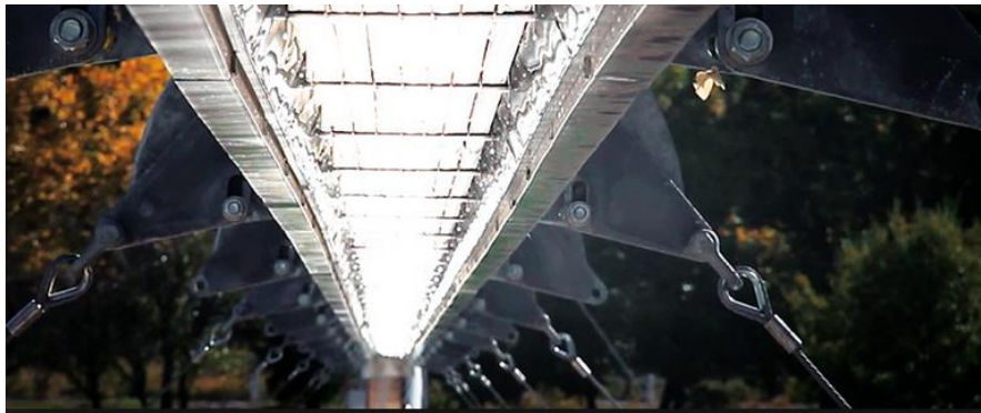
Figura 3.74. Cavidad receptora multitubo cerrada con espejos secundarios CPC aislados térmicamente. Fuente: (Alsolen Alcen, 2015).
