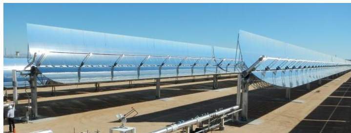
Figura 3.5. Concentrador Heliostats en SCA de 190 m de longitud. Fuente: Flagsol GmbH. (Heliostats)
