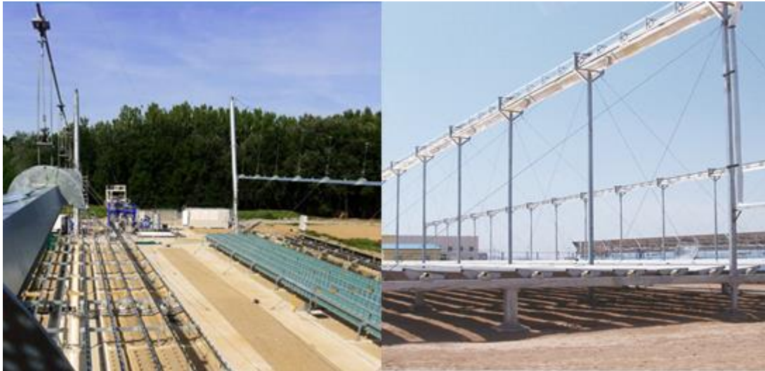
Figura 5.26. Torre de soporte de poste vertical uniformemente distribuido. Fuente: Alsolen Alcen y Lanzhou Dacheng
