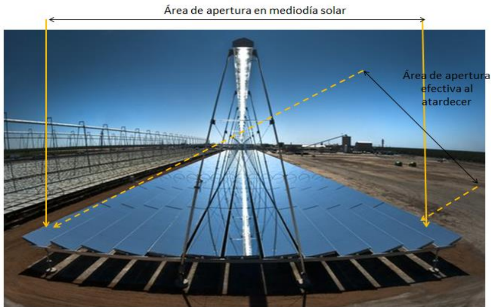
Figura 3.32. Pérdida de área de apertura efectiva en el seguimiento de la posición solar. Fuente: (Google imágenes).
