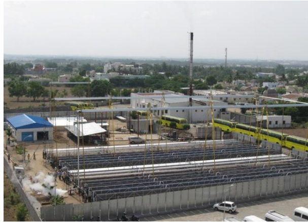
Figura 2.9. Centro de investigación de energía solar térmica en Coimbatore, India, basado en tecnología Fresnel de gran escala y producción directa de vapor saturado (DSG). Fuente: (KGDS, 2015).
