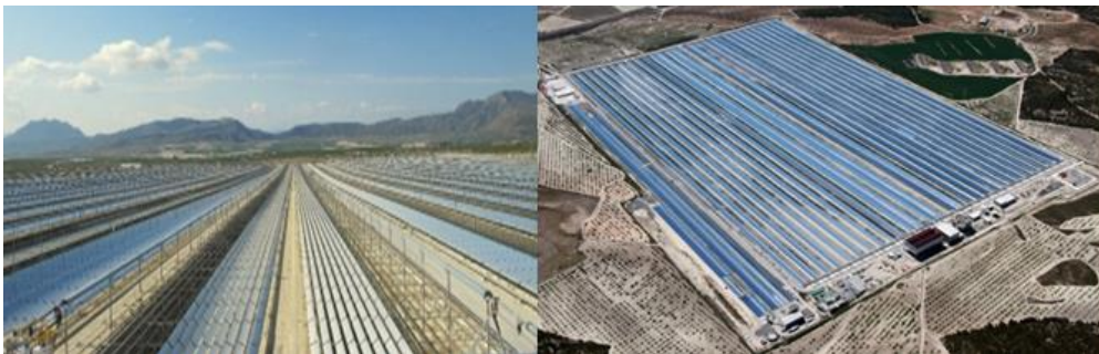
Figura 2.10. Vistas aéreas de la planta termosolar Puerto Errado 2 (PE2), de 30 MWe (150 MWt), en operación desde Agosto de 2012. Fuente: (Novatec Solar, 2015).
