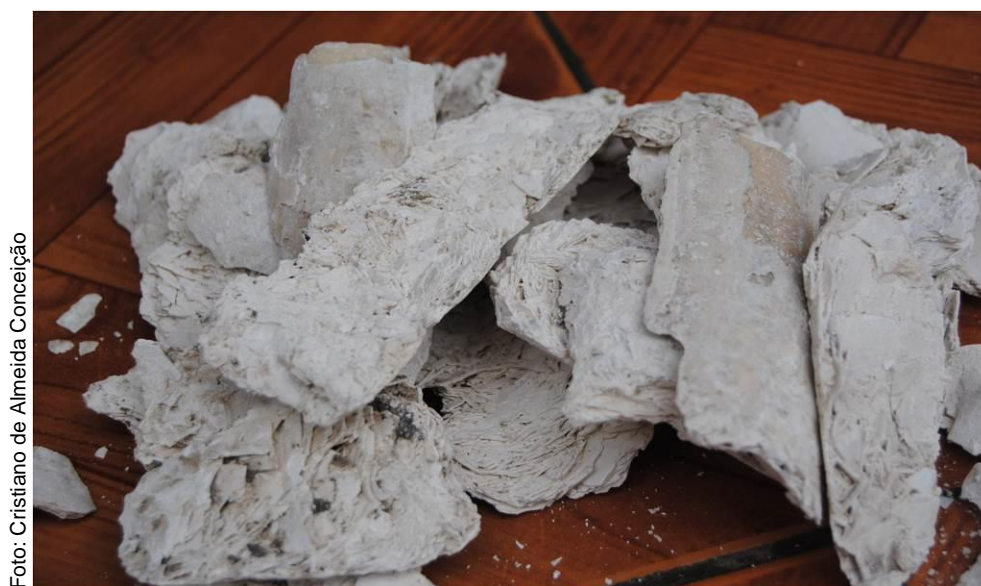
Figura 4. Sais de cálcio precipitados dentro dos canos de água provocando entupimento dos mesmos, assentamento Taquaral, Corumbá, MS.
