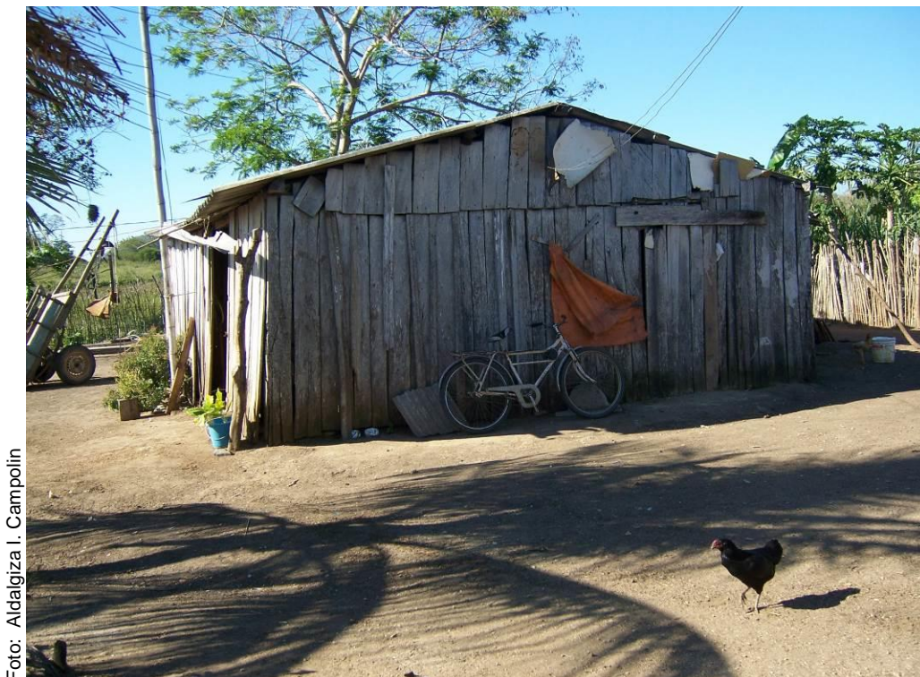
Figura 3. Residência em madeira no assentamento Taquaral, Corumbá, MS.
