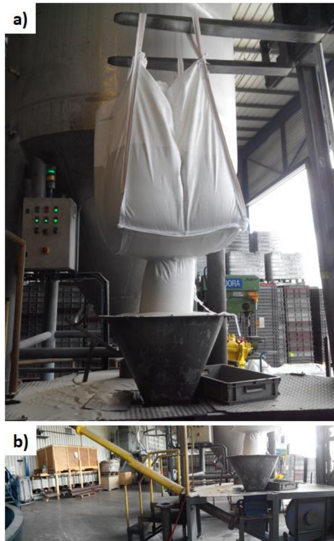
Figura 23: Big bag a ser vazado com a ajuda de um empilhador (a) e areia a ser transferida para o silo interior (b).
