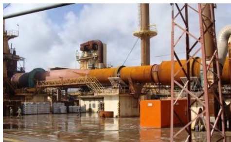
Figura 5-Forno rotativo (Saint-Gobain Weber)
