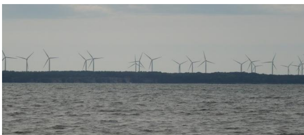
Pakri poolsaarel asub Eesti suurim tuulikupark. Avamere-tuulikuparke alles (õiguslikus vaakumis) planeeritakse.
