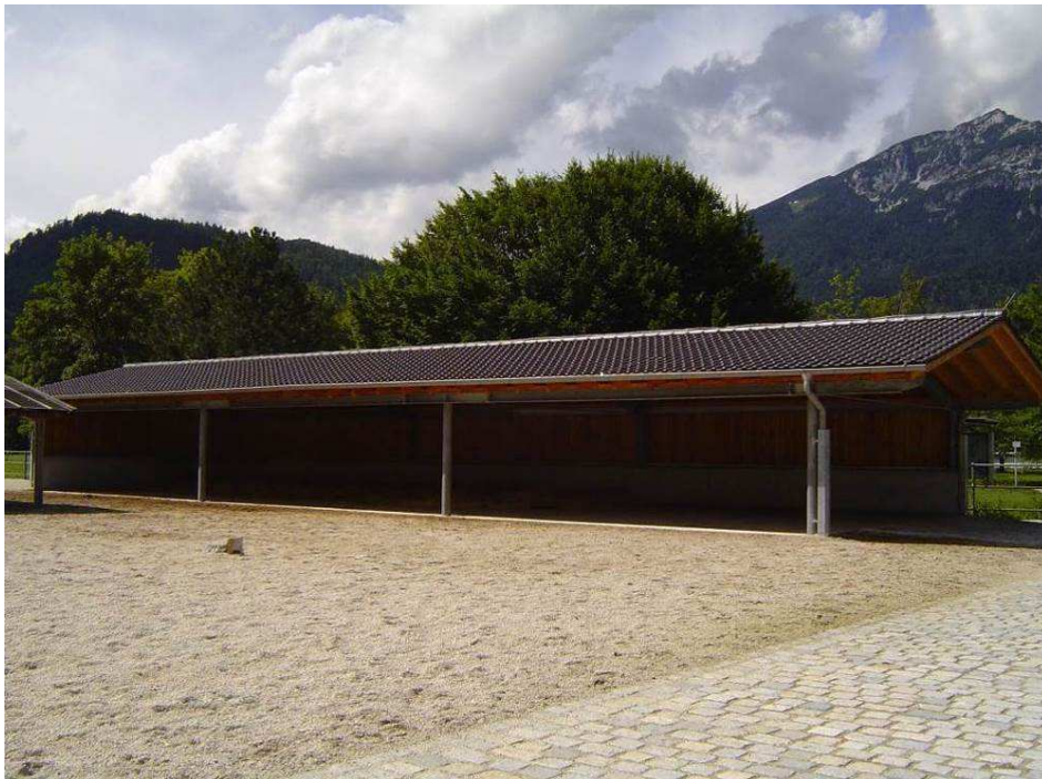
Abbildung 7: An zwei Seiten geschlossener Witterungsschutz mit Strohmattreze im hinteren Bereich und befestigter Unterstellfläche. Im Vordergrund Pflasterbereich im Bereich der Tränken.
