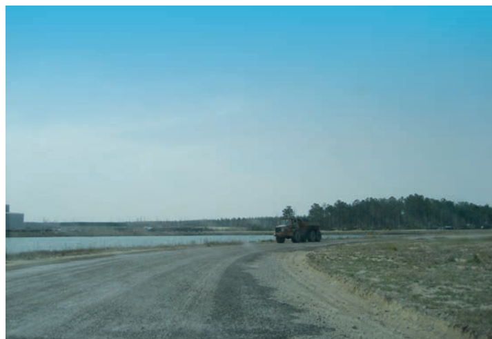
Figure 8 Les agrégats de laitier d'aciérie produits sur le site Nucor de Cofiled, North Carolina mis en œuvre dans une couche de base avant couverture par une couche de béton d'asphalte
