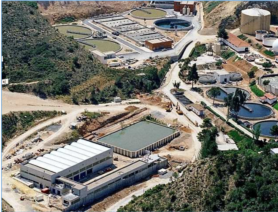
Figura 7. EDAR de Benidorm (Alicante) (fuente: EPSAR)
