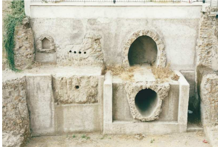
Figura 4. Sección transversal de una calle romana con distintos tipos de alcantarillas.
