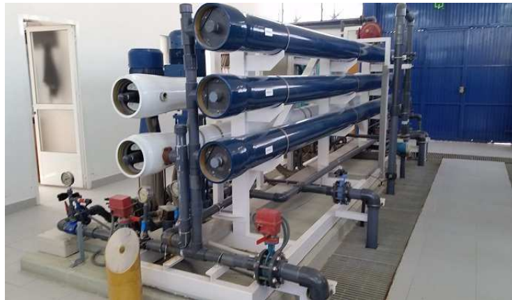
Figura 12. Tubos de presión de la desalinizadora de la Universidad de Alicante
