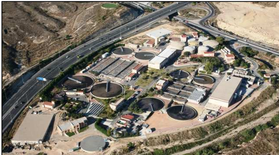
Imagen 1. Vista aérea de la EDAR “Rincón de León” (Alicante).
