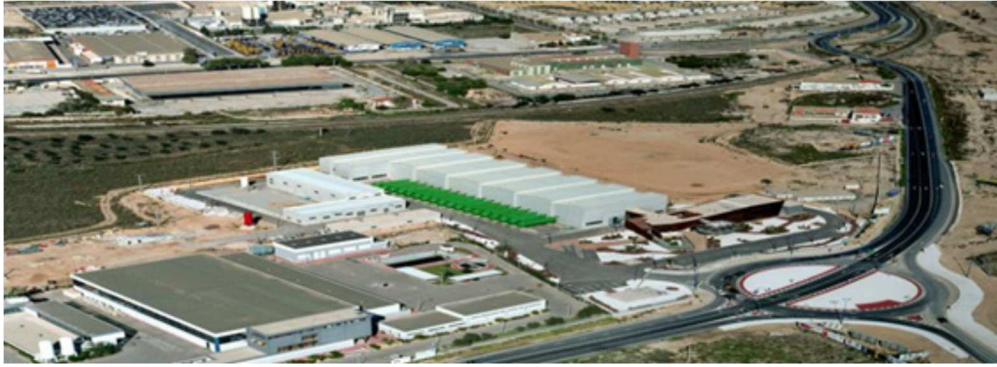
Desaladoras Alicante I y II de la MCT. Fuente: MCT.
