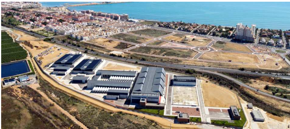
Desaladora de Torrevieja. Fuente: Acciona-Agua.
