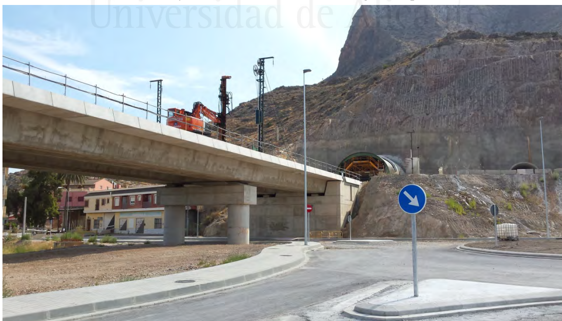
Foto 66. Trazado y obras del AVE. Callosa de Segura. Septiembre 2015
