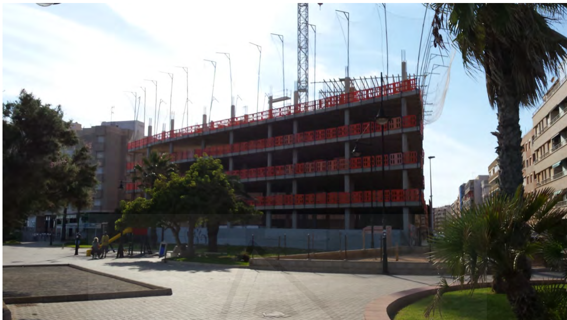
Foto 68. Obras de edificación en primera línea, frente a la playa. Torrevieja. 2015.
