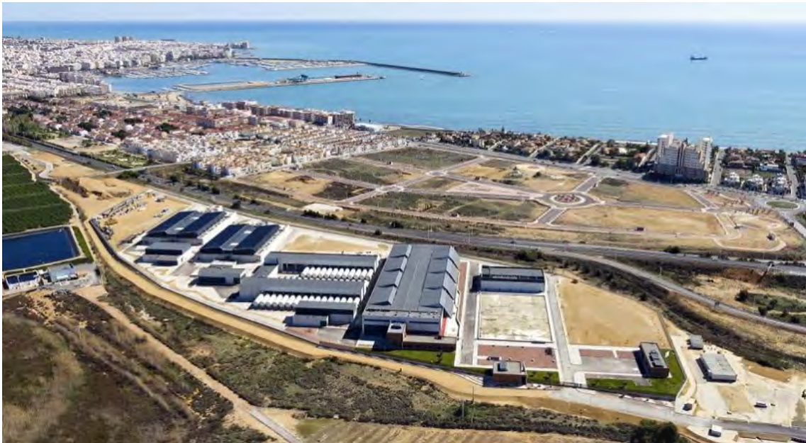
Desaladora de Torrevieja, 2014
