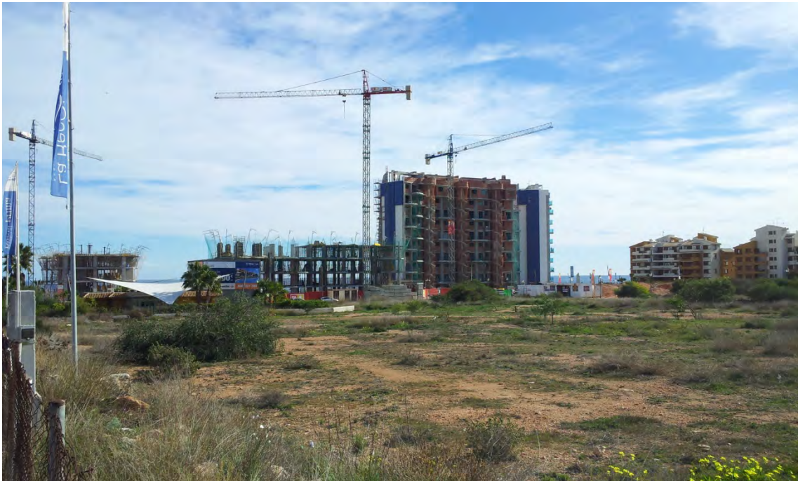
Foto 74. Obras en Punta Prima. Torrevieja, 2015.
