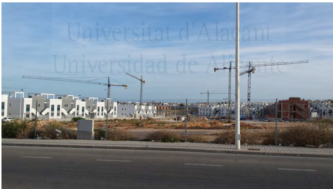
Foto 69. Obras en edificaciones. Torrevieja, 2015.
