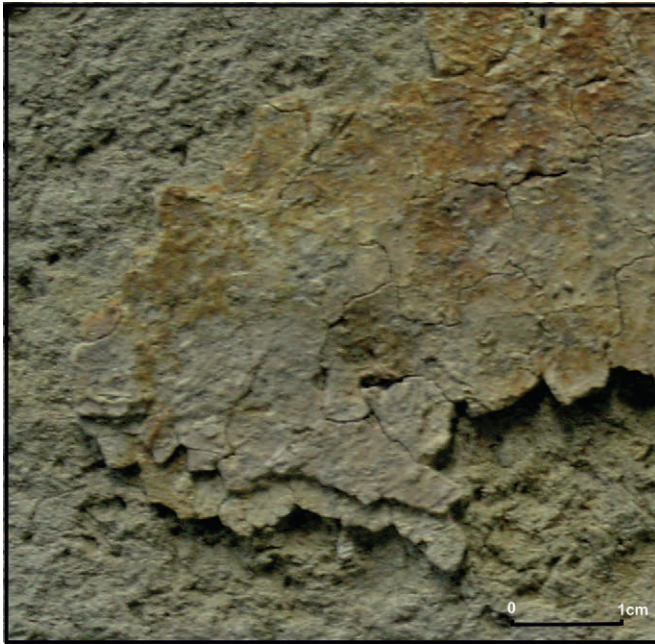
Fig. 9. Detalle fotográfico de las diferentes capas, a modo de enlucidos, conservadas en uno de los fragmentos de barro analizados de La Torreta-El Monastil.
