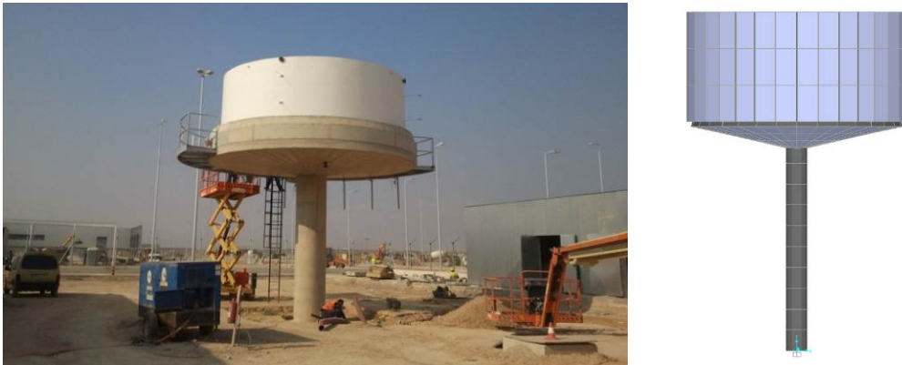
Figura 6. Estructura propuesta nº2. Izq.: Ejemplo real de estructura de hormigón. Drcha.: Modelización numérica mediante elementos finitos
