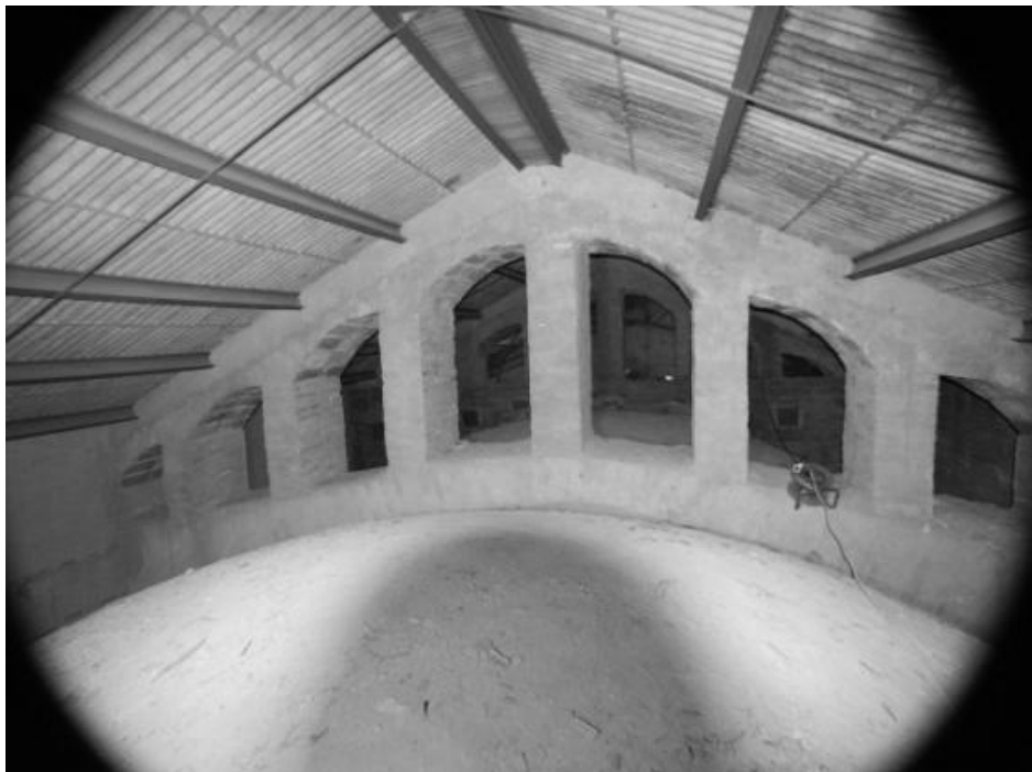
Fotografía de la sobre-cubierta de la nave principal.
