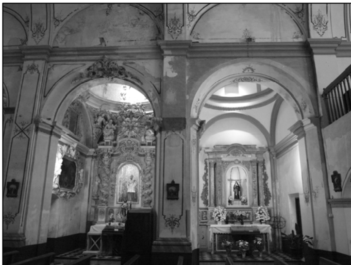
Vista de los arcos que dan acceso a las capillas laterales.
