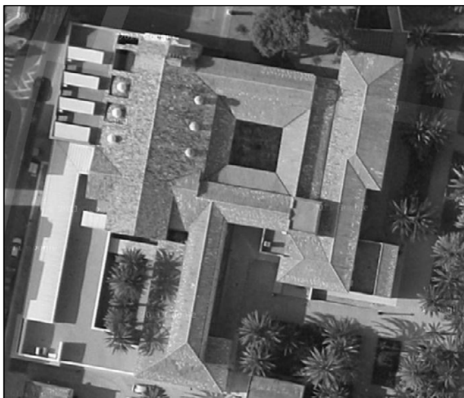
Vista aérea del convento de San José y sus cubiertas. Fuente: Google Earth.
