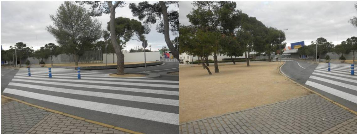
En la Figura 2, Zona A, se observa la discontinuidad en el recorrido debido al cambio de material existente, pasando de un adoquinado a un pavimento poroso, albero.
