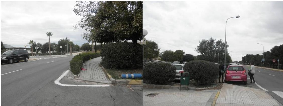
En la Figura 7, zona F, se detecta un bordillo en mal estado, que no se encuentra rebajado totalmente. En la zona G, se interrumpe el recorrido a pie por la aparición de vegetación y de una banda aparcamiento, que hace que nos obligue a desviarnos hacia el interior del Campus o a cruzar la calzada.
