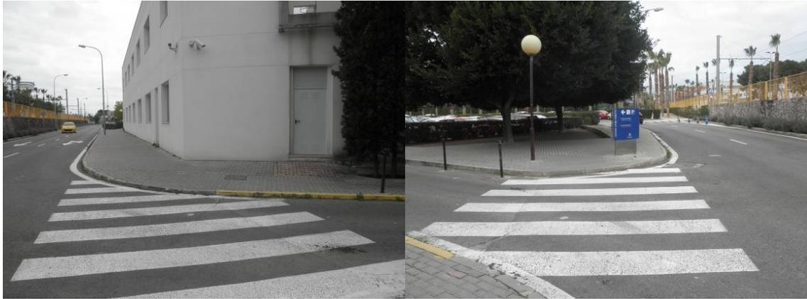
En la Figura 3, zona B, encontramos un paso de peatones con un bordillo no rebajado, con una diferencia de cota entre la acera y la calzada.
