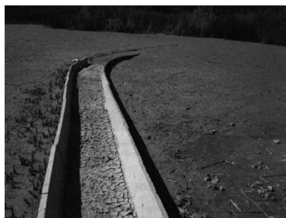
Figura 2: restos de la antigua conducción de aguas de «Zóñar» a Aguilar de la Frontera. Fuente: Junta de Andalucía.
