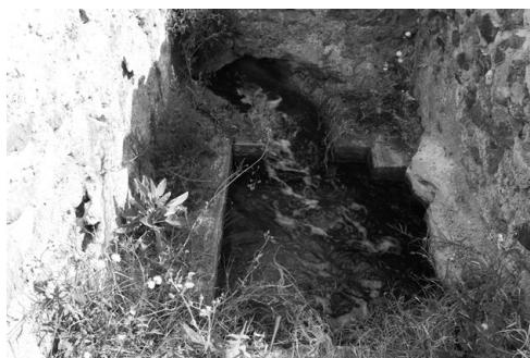
Figura 12. Arca o pilar, donde se parten las aguas alumbradas por la cimbra del Rincón o Atenores, en Guazamara (Cuevas del Almanzora). Fuente Gómez Espín, J, M.ª 16/03/2015.
