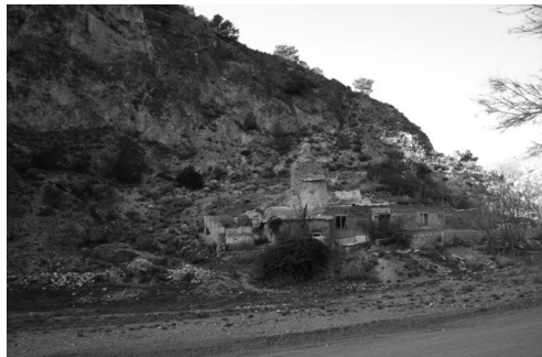
Figura 12. Molino hidráulico de cubo en la margen derecha de la rambla de Oria, aguas abajo de la Boca de Oria. Fuente: Gómez Espín, J.M. a 14/01/2015.
