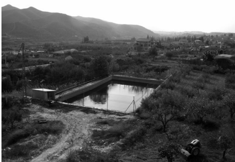
Figura 5. Balsa que recibe las aguas alumbradas por la cimbra Fuente del Beneficiado de Fines. Fuente: Gómez Espín, J.M.ª 13/03/2015.
