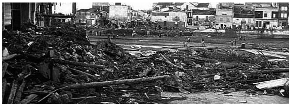
Figura n.º 5. Arriba: La canalización de la rambla de Nogalte al paso de la crecida de 2012 por el núcleo de Puerto Lumbreras. Abajo: El mismo sector tras la inundación de 1973.
