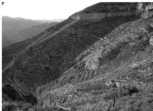
Figura 6. Terrazas en La Pileta (Penya de Sella), construidas en condiciones extremas sobre pendientes superiores al 70%, entre las altitudes de 825 y 950 msnm. Algunas presentan dimensiones muy reducidas, válidas pese a ello para el cultivo de cereales y algún pie arbóreo de almendro o higuera. Fotografía del autor (2004).
