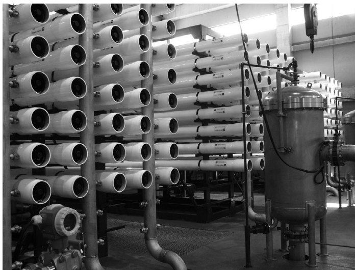
Figura 3. Los avanzados sistemas de tratamiento terciario, con empleo de desalinización, se han implantado en depuradoras de Alicante como Benidorm y Rincón de León. En esta última, con técnica de ósmosis inversa, se producen 25.000 m 3 /día de agua residual desalada para el riego de unas 13.800 ha del Vinalopó y Campo de Alicante.
