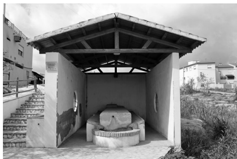
Figura 17. Lavadero rehabilitado que recibía las aguas del Pilar de la Ermita Vieja, en la margen derecha de la rambla de Guazamara (Cuevas de Almanzora). Fuente: Gómez Espín, J.M. a 04/04/2015.
