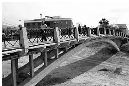
Fig. 7. Puente de la Torta sobre la Rambla de Tiata
