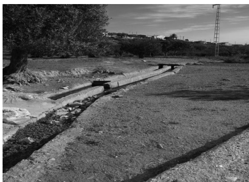
Figura 8. Conducciones de distribución de las aguas alumbradas por la cimbra de la Fuente de Las Mercedes. Fuente: Gómez Espín, J.M. a 14/01/2015.
