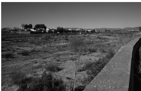
Figura 3. Encauzamiento de la Rambla de Albox, entre el núcleo del Pueblo y la entidad de La Loma construido tras la avenida del 19 de octubre de 1973. Fuente: Gil Meseguer, E y Gómez Espín, J.M. a 04/01/2015.
