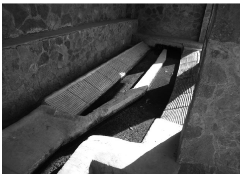
Figura 7. Lavadero rehabilitado, a continuación de la bocamina de la cimbra de la Fuente de Las Mercedes, en la margen izquierda de la rambla de Oria. Fuente: Gómez Espín, J.M. a 14/01/2015.
