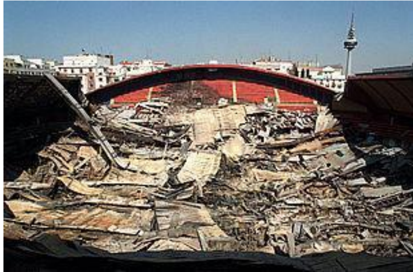
Fig. 5 Estado posterior Incendio Fuente: http://elpais.com/diario/2001/06/29/espana/993765622_850215.html
