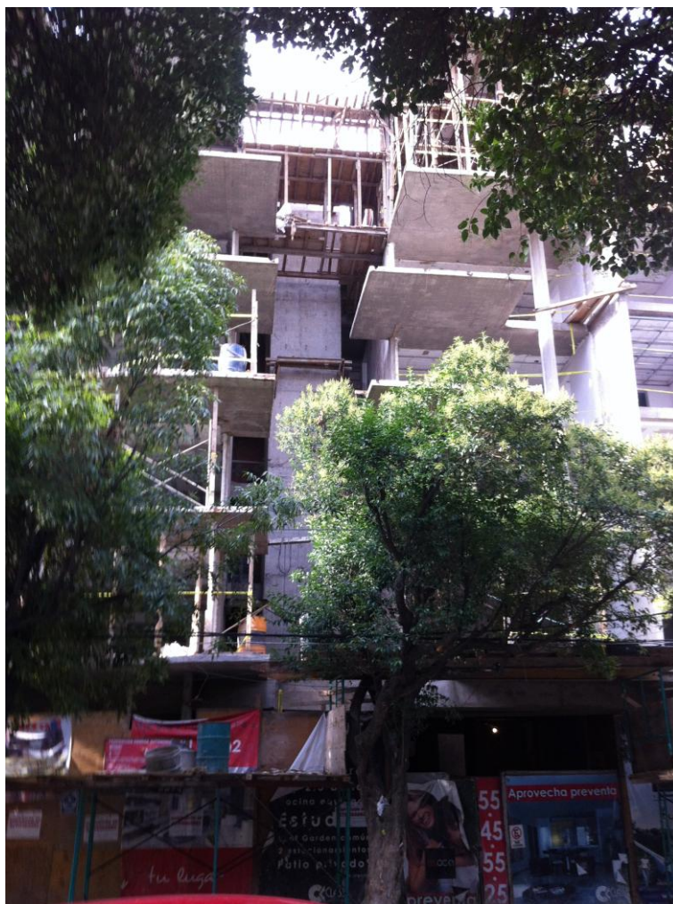
Edificio que sobrepasa los 3 niveles de altura permitidos y realizado sobre un predio catalogado por el INBA. Autor: Luis Salinas (junio de 2011).
