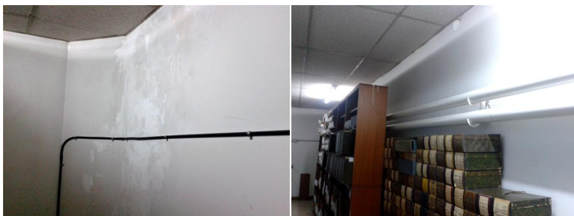
Fig. 170 i 171. El canvi de coloració a la paret ens fa veure l'aplicació de massilla per esquerdes i/o problemes d'humitat; dues canonades passen per darrere l'armari on es conserva el fons de portades. Font: Autora.
