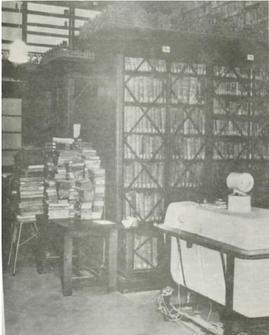
Fig. 3, 4 i 5. Autoclau portàtil per a la desinsectació de 1970; autoclau instal·lat a la Biblioteca Universitària per a la desinsectació de 1934; cambra mòbil per a la desinsectació de 1972. Font: Memòria 1971-1972, 1972:13.
