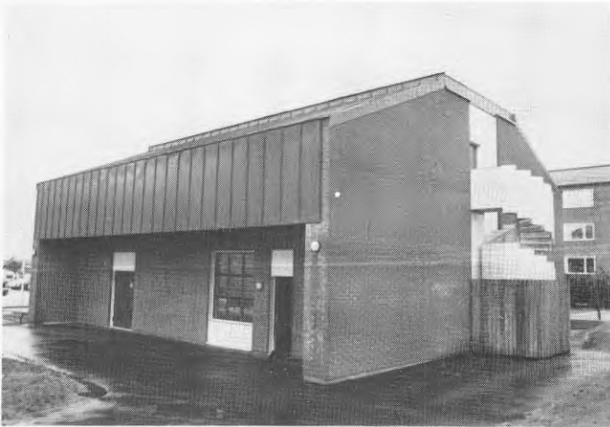
Figur 3.1. Foto över värmepumpcentralen i Brunnsbergsområdet, Varberg.
