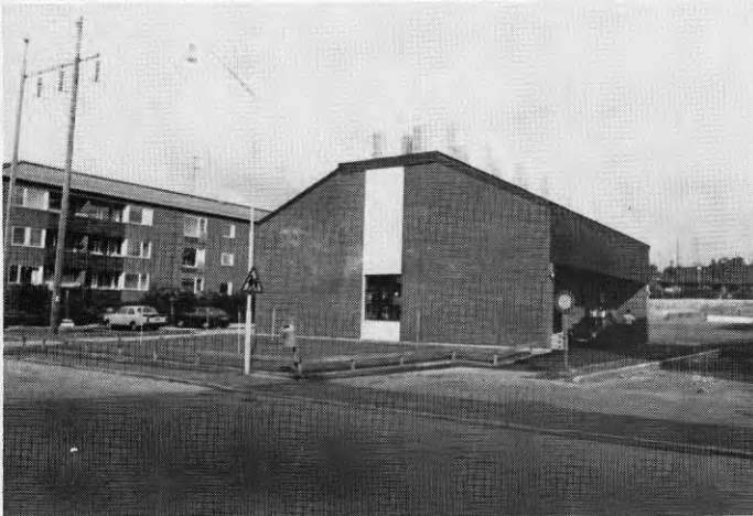
Figur 0.1. Foto över värmepumpcentralen.
