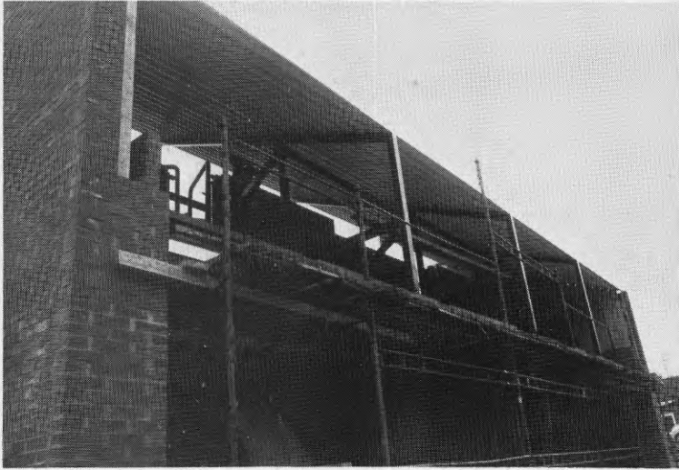
Montering av luftkylbatterier under bygghetiden.
