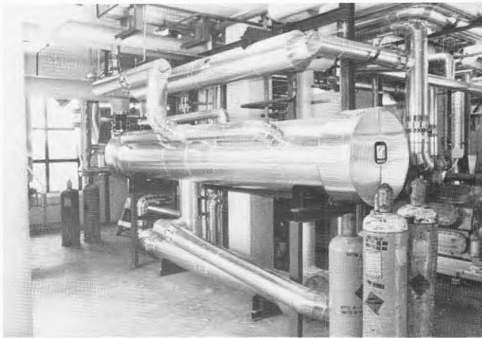
Figur 1.1. Foto på värmepumpens värmeväxlare.
