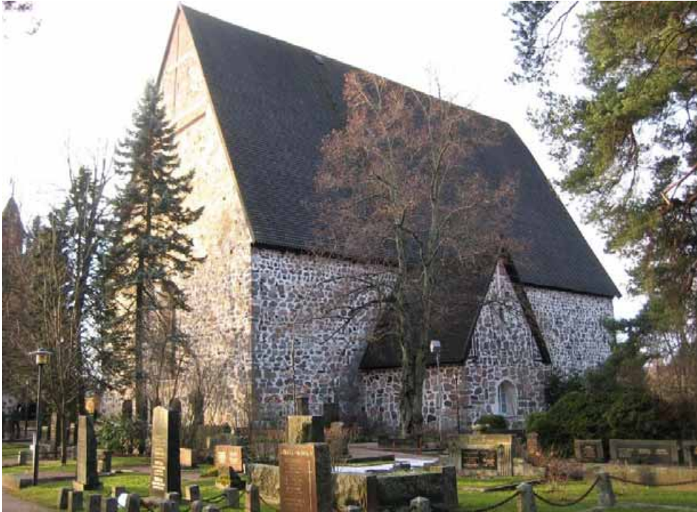
Kuva 6.14 Lohjan kivi-kirkko sijaitsee pappilan kanssa samalla pitkänomaisella kumpareella vesitse ja maitse suhteellisen helposti saavutettavalla paikalla. Kuva Päivi Maaranen 2011.
