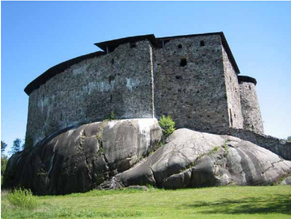
Kuva 6.23 Raaseporissa sijaitsevan Tammissaaren Raaseporin linnan vaikuttavuutta menneisyydessä on vaikea arvioida luotettavasti, sillä nykymuodossaan rakennus on restauroinnin tulosta. Kuva Päivi Maaranen 2008.
