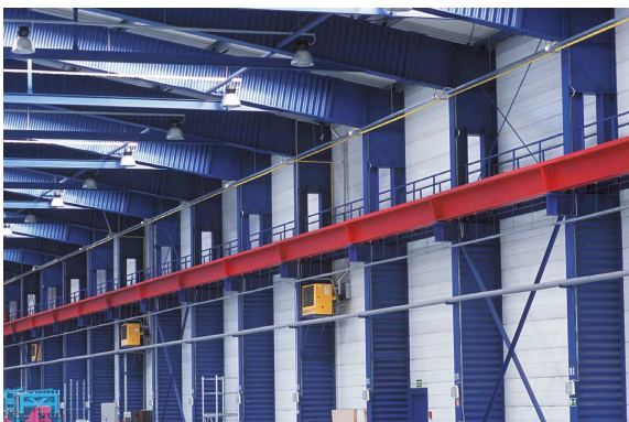
(a) estrutura porticada de um edifício industrial
