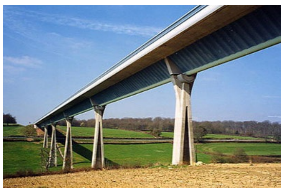
(a) Ponte com secção prismática em caixa – viaduto Maupré (1988), França
