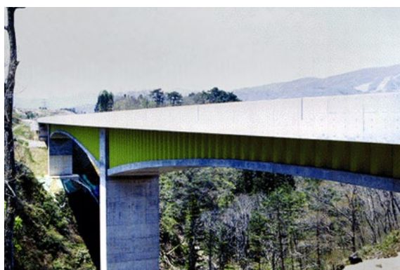
(b) Ponte com secção em caixa de inércia variável – ponte Hondani (1997), Japão
