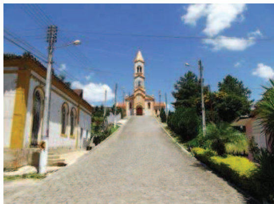
Figura 104: Igreja de São Marcos vista da Rua São Marcos.
