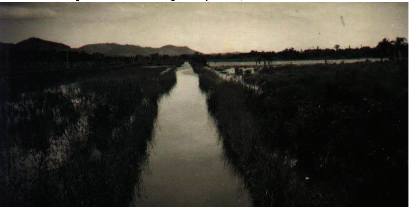
Figura 18: Estrada Urussanga – Estação Cocal, enchente de 1950.
