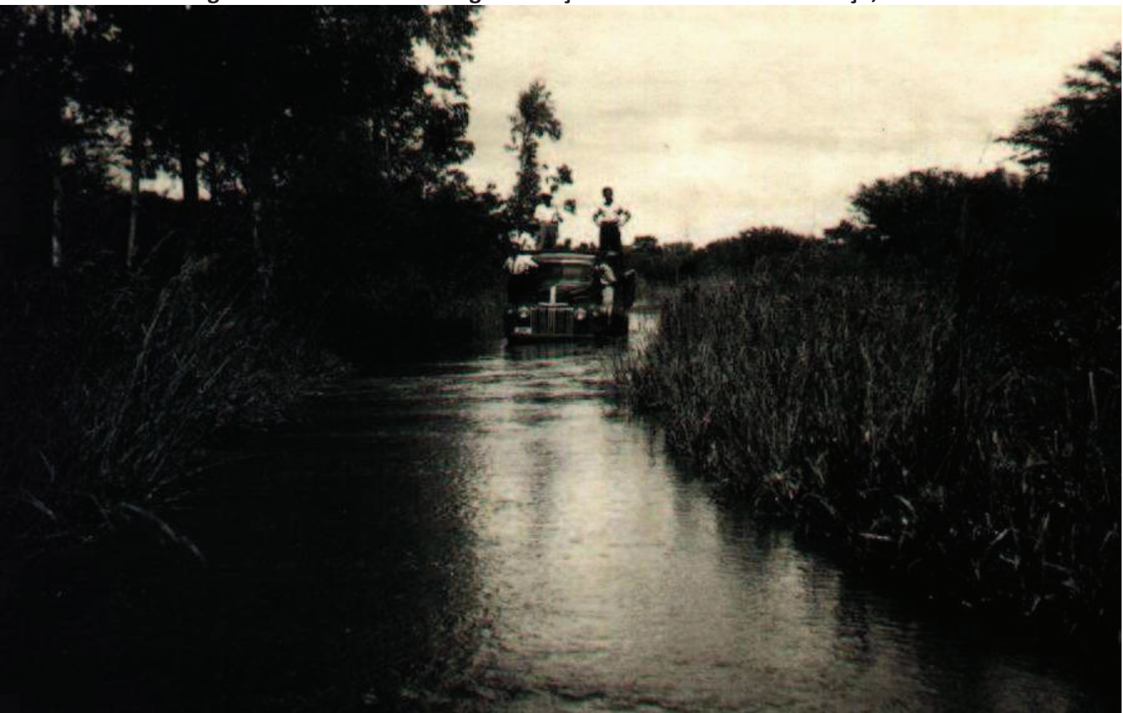
Figura 48: Estrada Urussanga – Estação Cocal – Morro da Fumaça, 1950.
