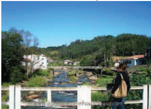
Figura 62: Ponte sobre o Rio Pedras Grandes, sede do município.
