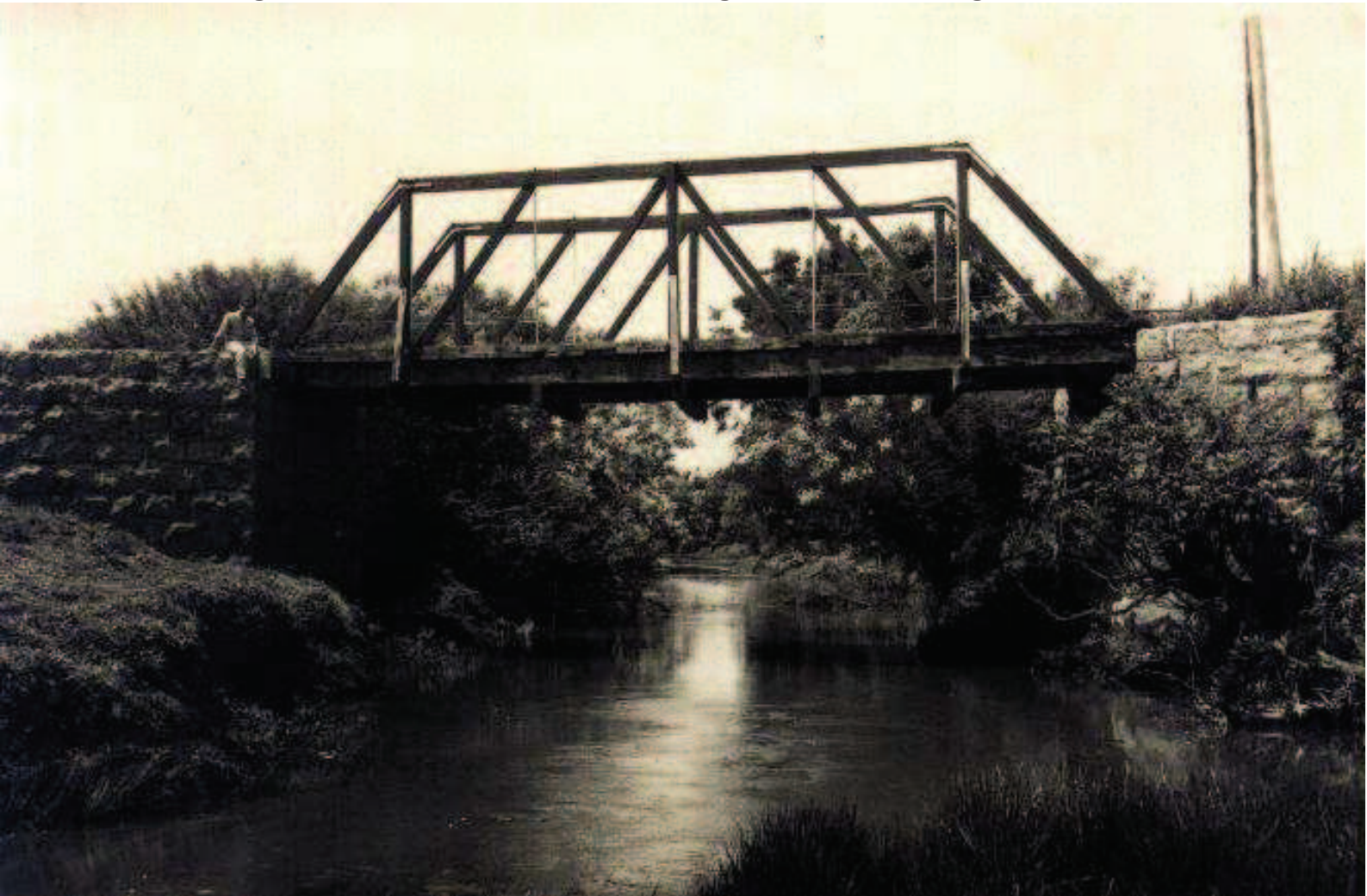
Figura 144: Ponte sobre o Rio Urussanga, estrada Urussanga – São Pedro, s.d.
