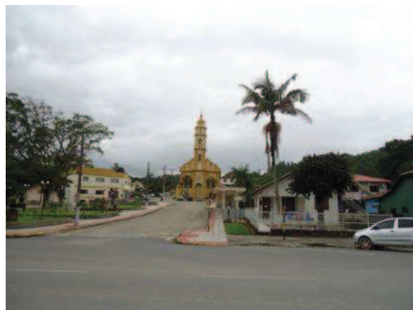
Figura 120: Sede do município de Pedras Grandes.
