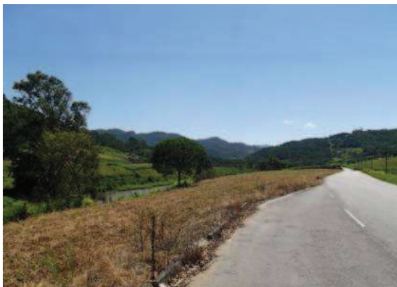
Figura 84: Estrada às margens do Rio Tubarão.
