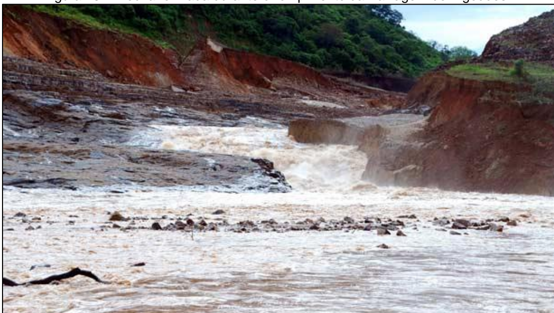
Figura 15 - Brecha formada durante o rompimento da Barragem de Algodões I.
