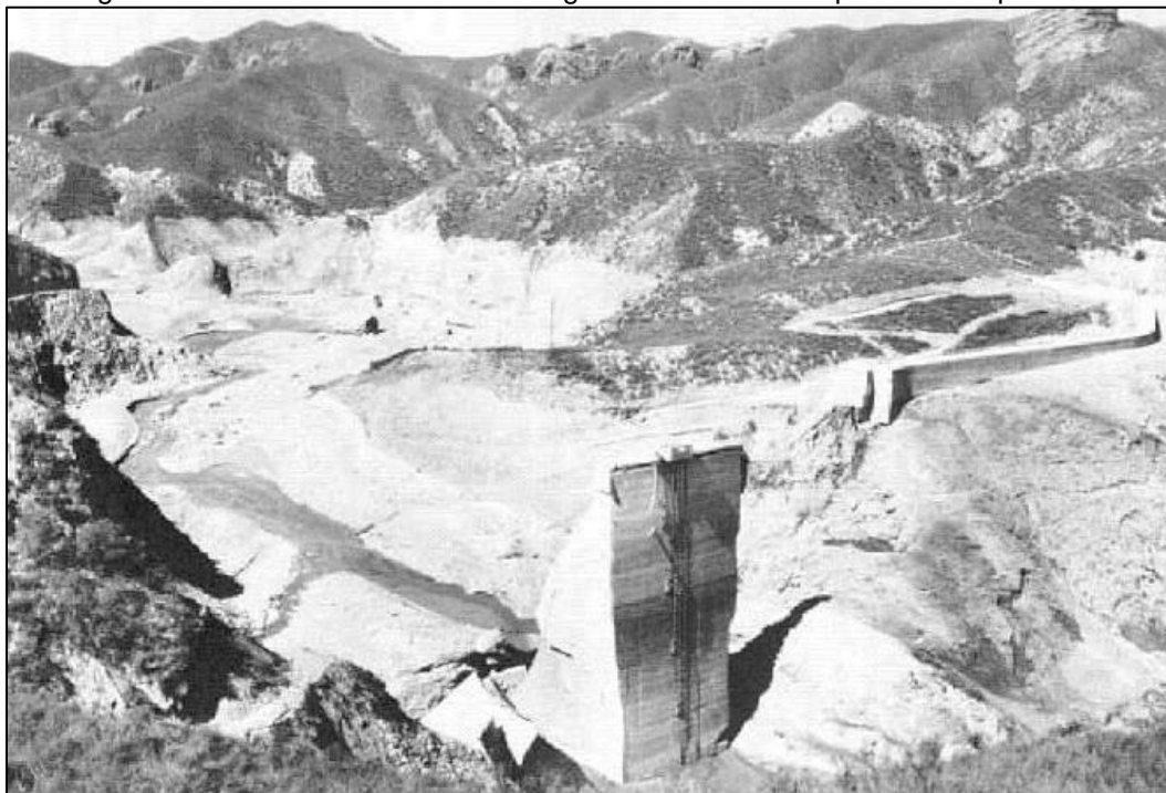
Figura 7 - Vista de montante da barragem de St. Francis após seu rompimento.
