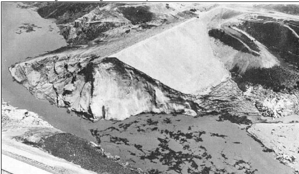
Figura 11 - Barragem de Teton após o esvaziamento do reservatório.
