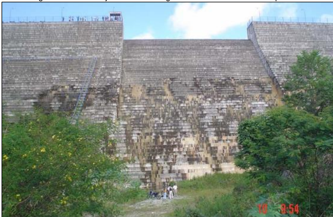
Figura 12 - Vista de jusante da Barragem de Camará antes do rompimento.
