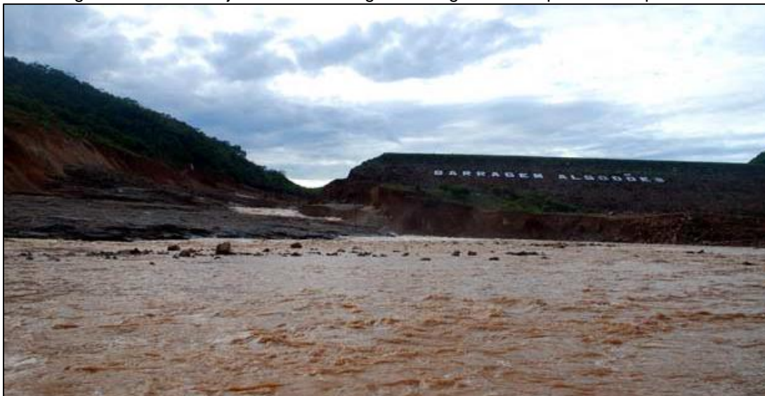
Figura 14 - Vista de jusante da Barragem de Algodões I depois do rompimento.
