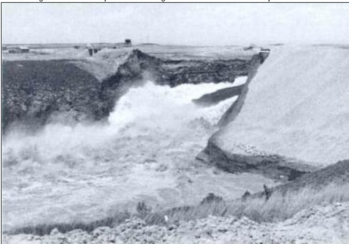
Figura 10 – Vista de jusante da barragem de Teton durante a formação da Brecha.
