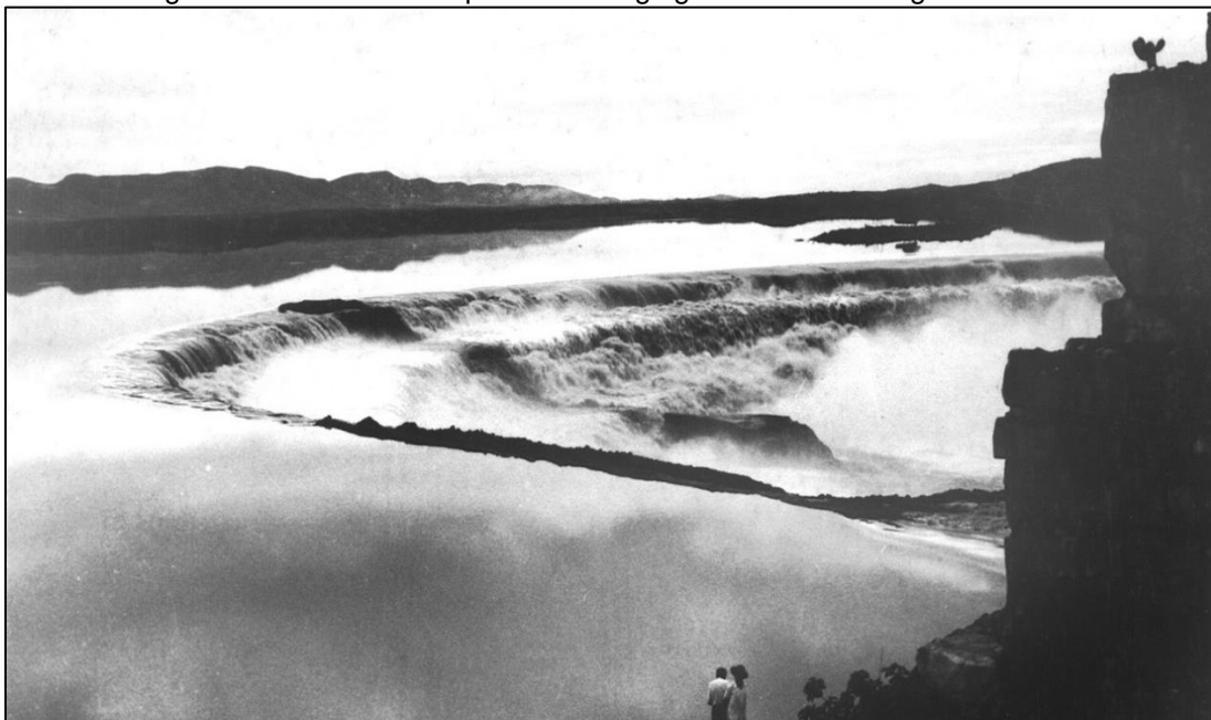
Figura 8 - Momento em que ocorria o galgamento da Barragem de Óros.
