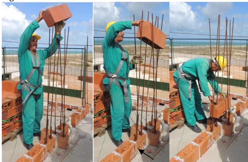
Figura 7.30 – Assentamento de blocos.
