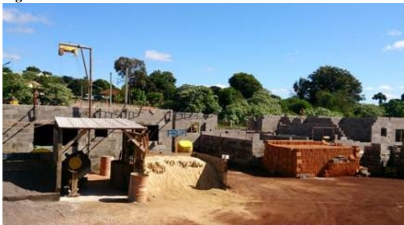
Figura 7.5 – Canteiro da Obra C.
