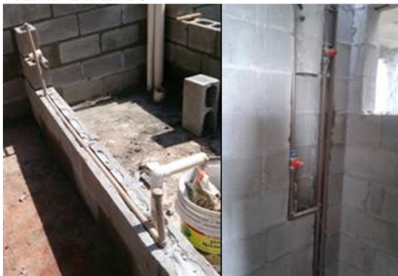
Figura 7.19 – Rasgos na alvenaria para passagem de tubulação hidráulica nas obras B e C.
