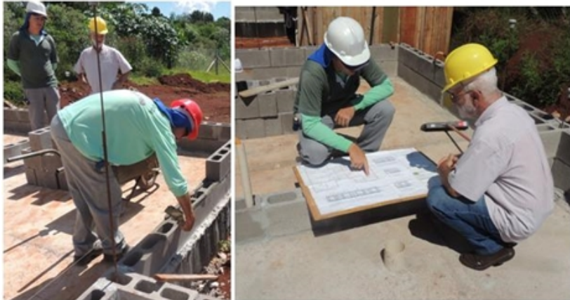
Figura 7.26 – Aula prática na obra C.
