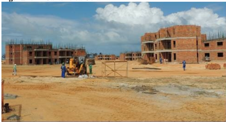
Figura 7.1 – Canteiro da Obra A.
