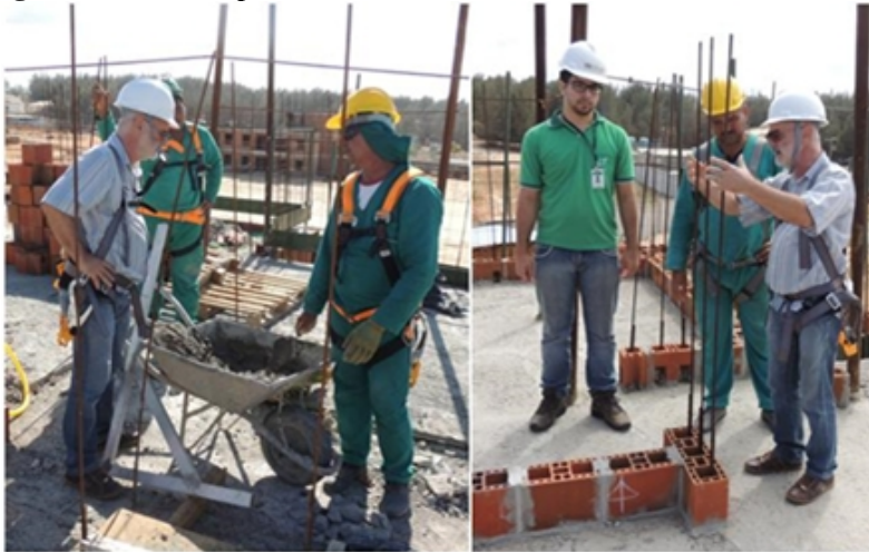
Figura 7.24 – Aula prática na obra A.
