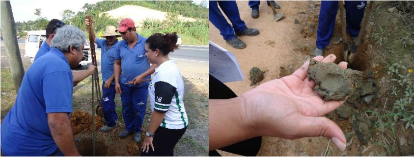
(a) Execução tradagem
