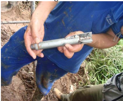
Figura 15 – Sondagem com penetrômetro dinâmico leve com circulação de água
