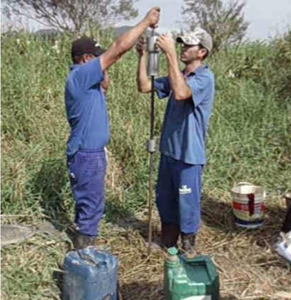
Figura 11 – Execução do ensaio Penetrômetro Dinâmico Leve (DPL)
