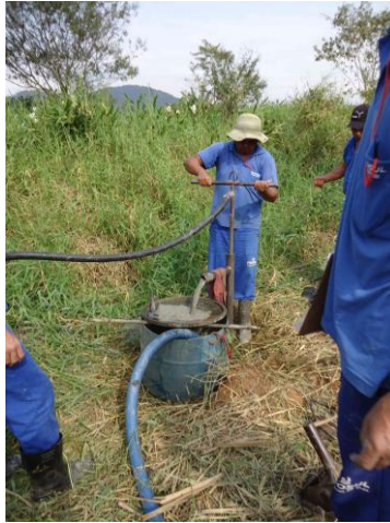
c) Lavagem do furo
