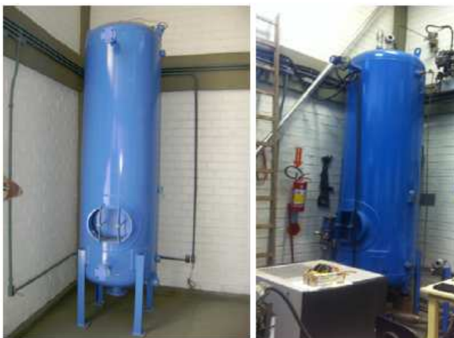
Figura 4 – À esquerda Tanque de Pressão T-1 sem instrumentação. À direita, Tanque T-1 instrumentado.
