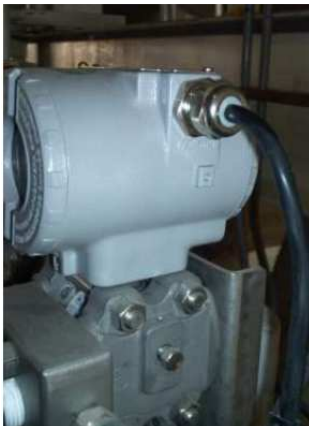
Figura 16 – Conexão do cabo ao instrumento (extraído de [13]).
