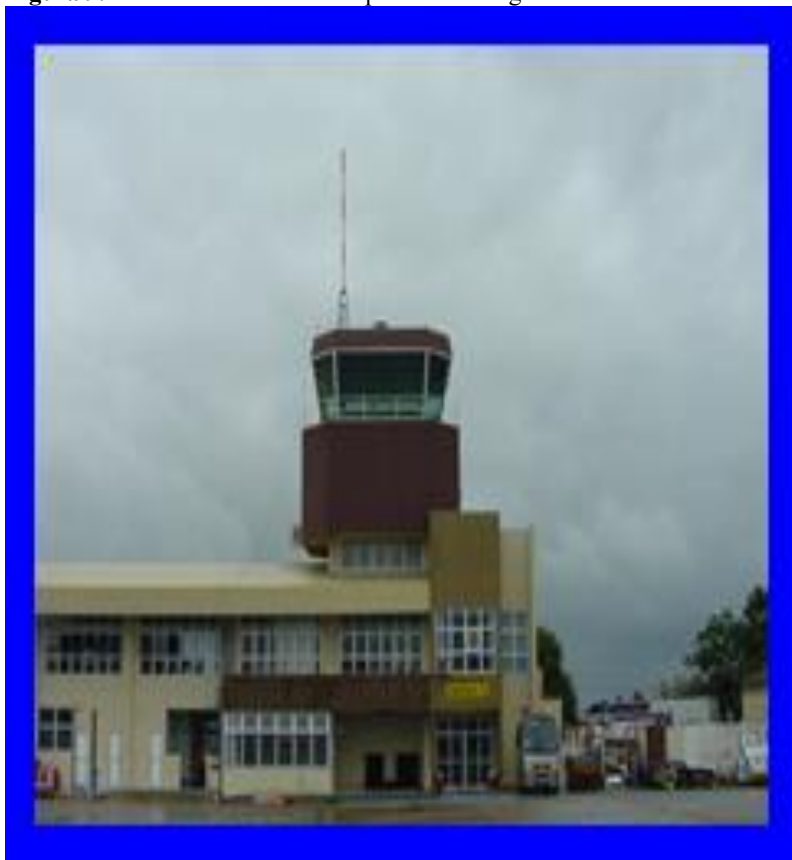
Figura 9. Torre de controle do aeroporto de Navegantes
