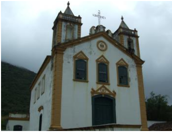
Figura 31 – Igreja Matriz Nossa Senhora da Lapa antes da reforma (Foto Marta Machado)
