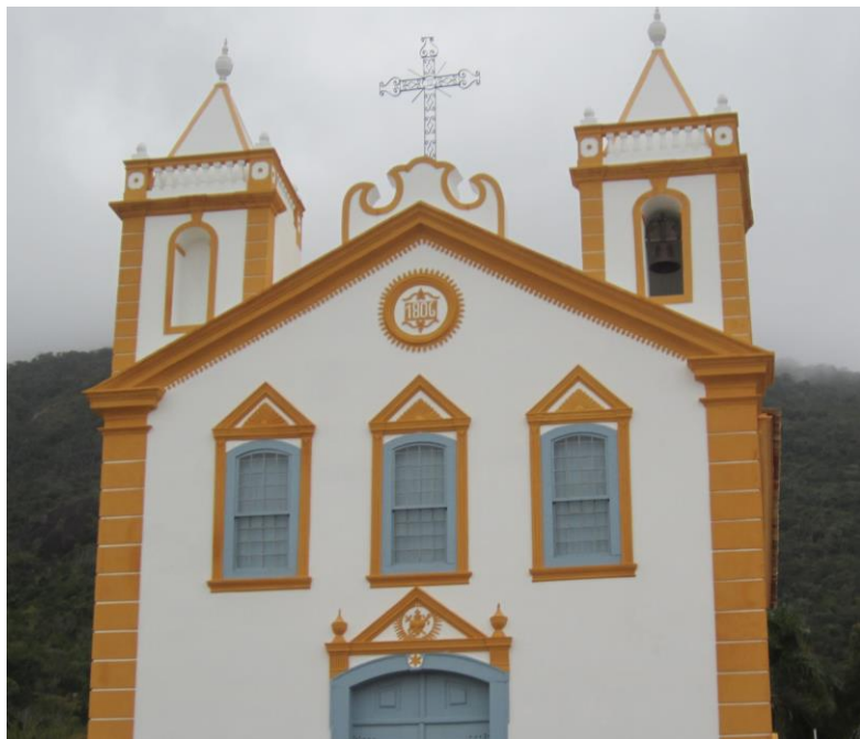
Figura 32 – Igreja Matriz Nossa Senhora da Lapa depois da reforma (Foto Marta Machado)
