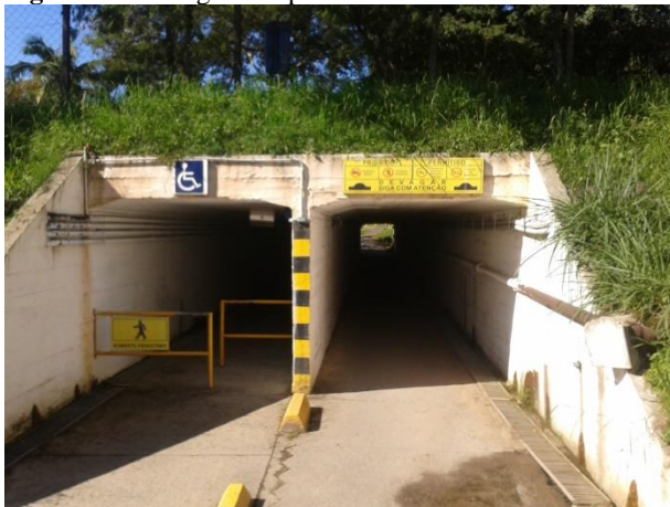
Figura 11. Passagens de pedestres e ciclistas sob a avenida
