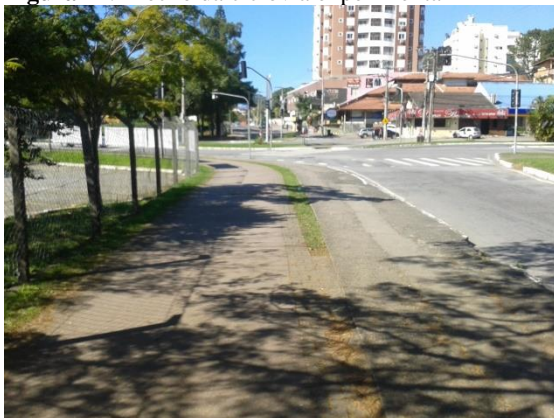
Figura 12. Trecho da ciclovia experimental
