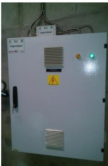
**Figura 57: Unidade de monitoramento instalado em uma usina hidroelétrica.**
