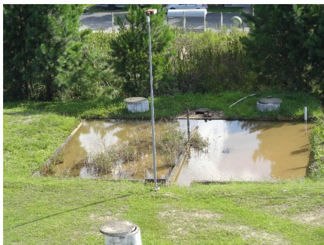
Figura 21. Estrutura desativada de tratamento de efluente.
