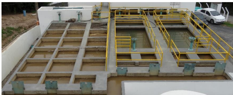
Figura 15. Unidades de tratamento da ETA.
