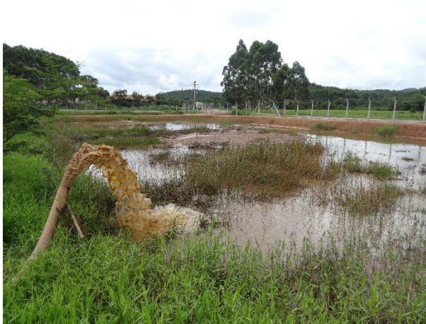
Figura 12. Local de lançamento do lodo retirado da lagoa de decantação.
