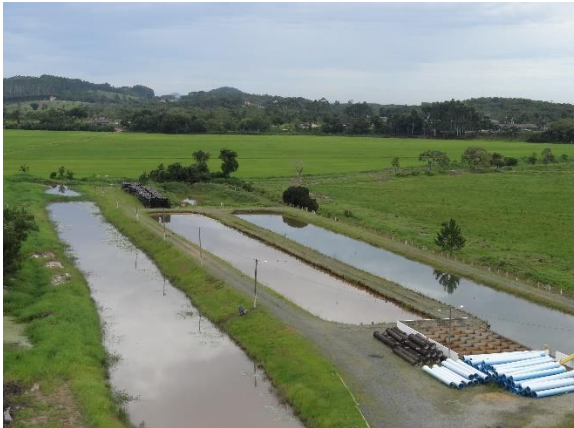
Figura 11. Lagoa de decantação da ETA.
