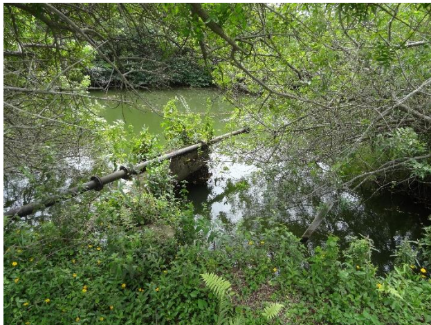
Figura 10. Local de lançamento do efluente na lagoa ao lado da ETA.
