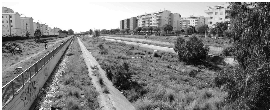
Figura 6. Cauce del río Guadalmedina.
