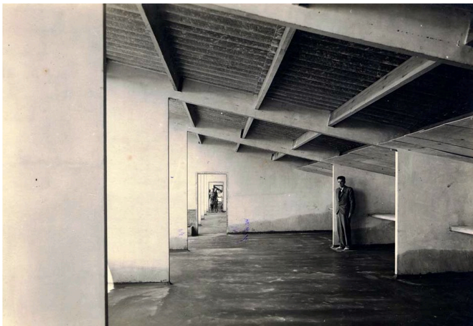
Fig. 4. Joan Roca en el interior de los gallineros de la planta superior durante su construcción.
