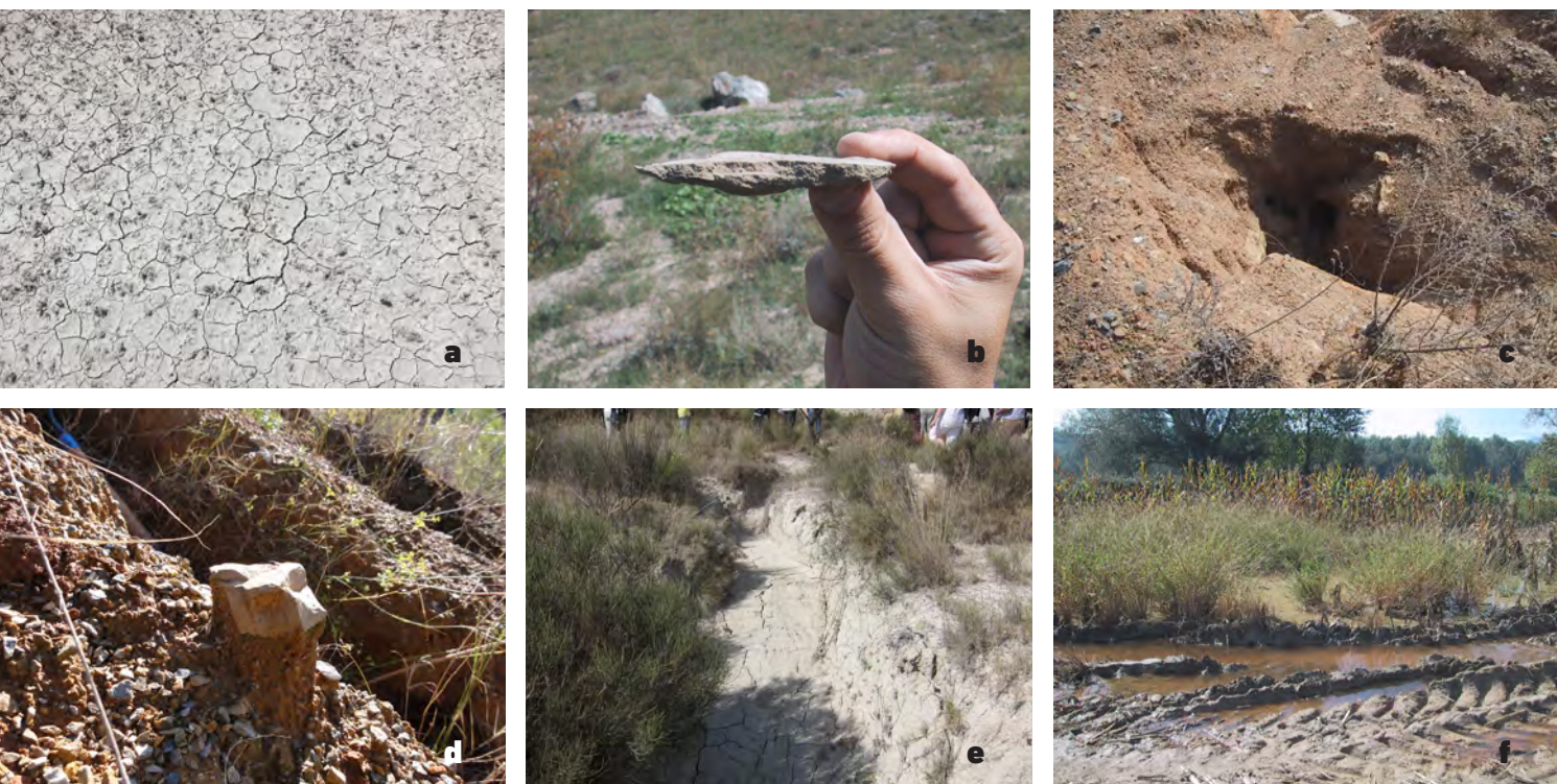
Figura 13. Procesos de degradación que pueden ocurrir en zonas restauradas, distintos a la erosión concentrada, e indicios de su presencia. De izquierda a derecha y de arriba abajo: formación de costra superficial (a), detalle de la costra (b), hundimiento por erosión subsuperficial debido a la composición y disposición del relleno (c), pináculo formado bajo una piedra resultante de la erosión circundante (d), acumulación de sedimentos producida por erosión laminar (e), y encharcamiento provocado por una baja capacidad de infiltración del suelo (f). (fotografías: V. Carabassa)
