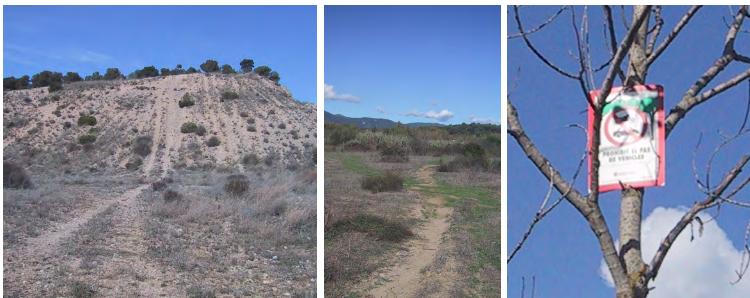
Figura 26. La circulación incontrolada de vehículos todo-terreno (izquierda), motocicletas (centro) u otros vehículos en las áreas restauradas es una práctica que se debe evitar. La colocación de carteles en estas áreas puede tener un efecto disuasorio (derecha), aunque la medida más efectiva es impedir el acceso (fotografías: V. Carabassa).
