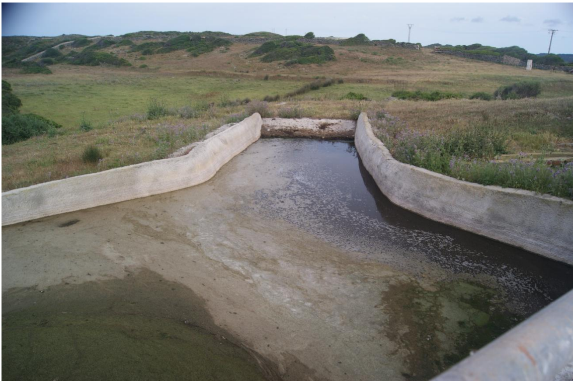
Figura 6.7. Fossa sèptica dels estables.
