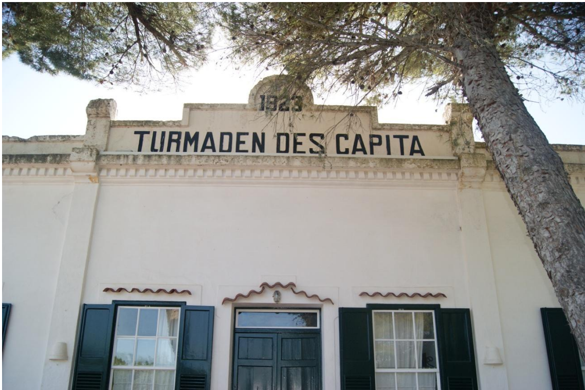
Figura 6.22. Façana de Turmaden des Capità.
