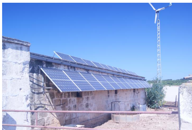
Figura 1.3. Instal·lació de les plaques solars de Es Tudons.
