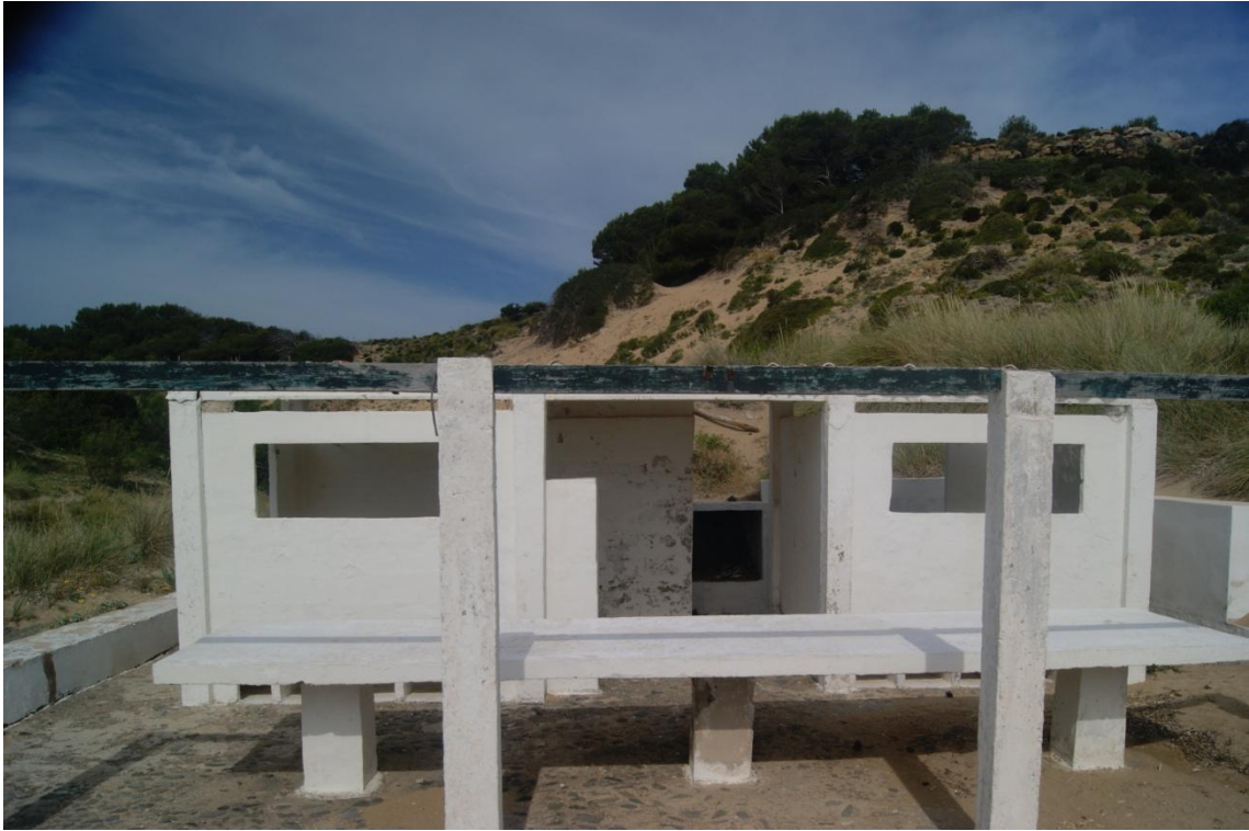
Figura 6.18. Mirador d'aus en la cala de s'Arenal.
