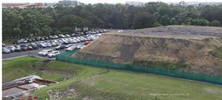
Fig.1E. Fotografia del sòl descontaminat apilat al parc industrial de Botany. Font: www.orica.com
