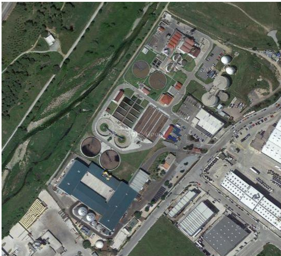
Figura 4.1. Vista aèria de la depuradora de Granollers Font: https://maps.google.es/
