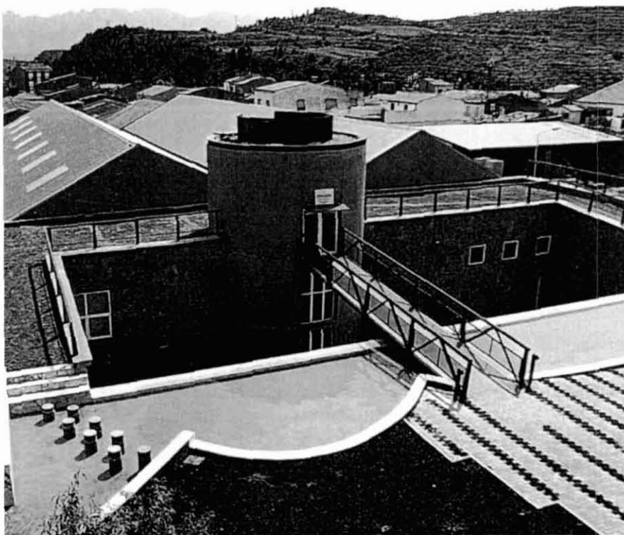
Perspectiva del Pont de Vilomara des de la Planta de reciclatge de frigorífics. (Fotografia: Tècniques de Protecció Ambiental, S.A.).
