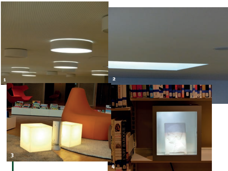
Système d'éclairage et puits de lumière : 1. Luminaires en forme de hublots. – 2. Bancs de lumière naturelle - 3. Boîtes lumineuses. 4. Vitrines lumineuses.
