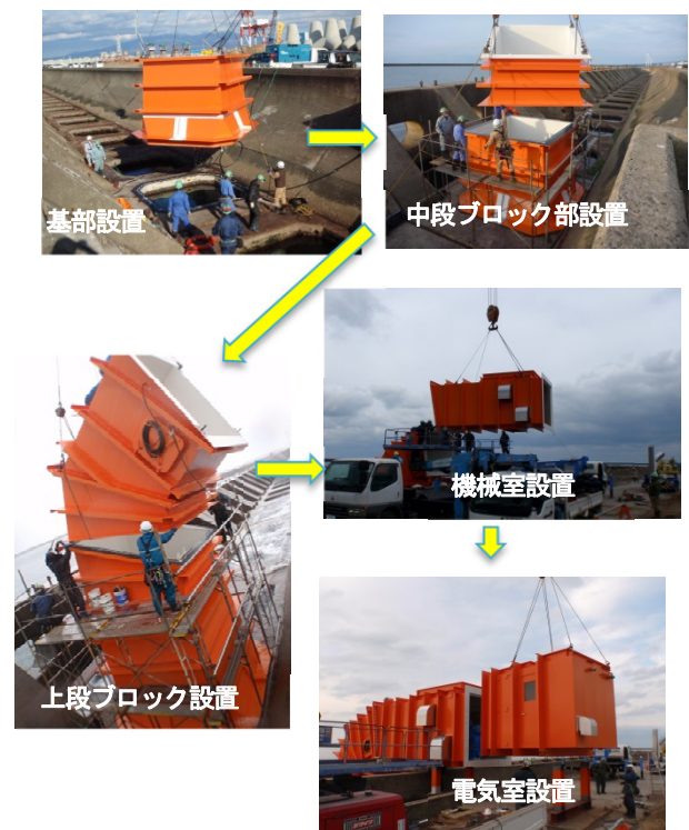
写真-2 発電装置設置状況(平成26年12月)
