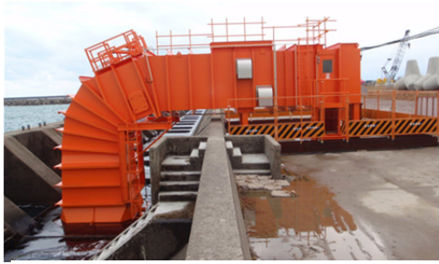
写真-3 波力発電装置完成(平成 27年 1月)
