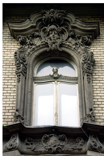
5. ábra: Kapcsolt gerébtokos ablak, Erzsébet körüti neobarokk (historizáló) stílusú épület ablaka
