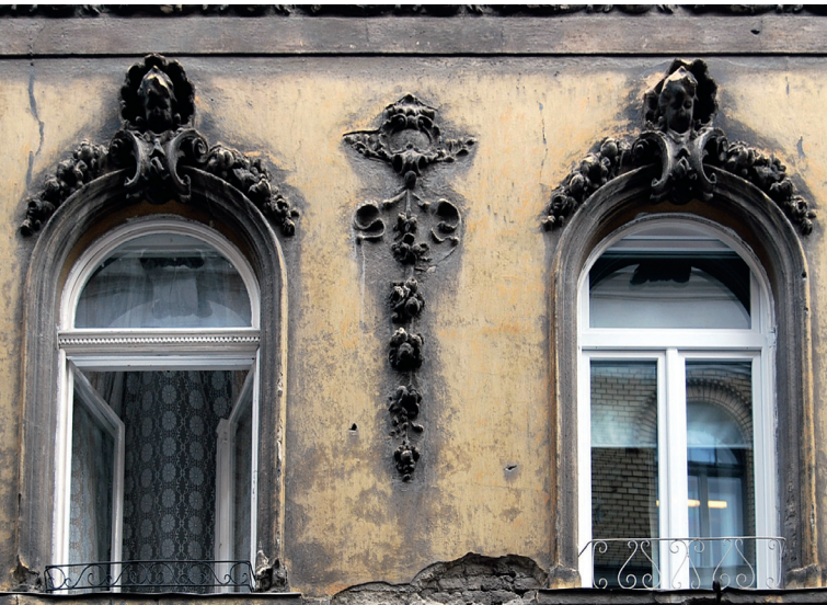
1. ábra: A cserélt nyílászárók megváltoztatják a homlokzat karakterét
