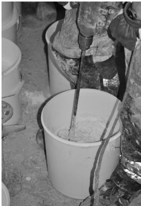
Kuva 9. Epoksimassan sekoitus. Epoksimassaa on usein työntekijöiden työvaatteilla, etenkin housujen reisosissa.
