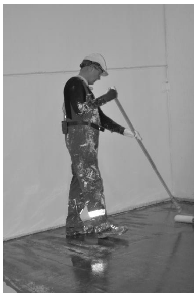
Kuvat 12-13. Lattiapinnoitteen levitystä tehdashallissa ja autotallissa.
