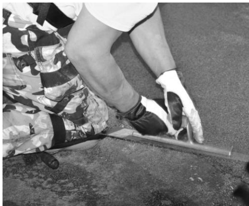
Kuvat 12-13. Lattiapinnoitteen levitystä tehdashallissa ja autotallissa.
