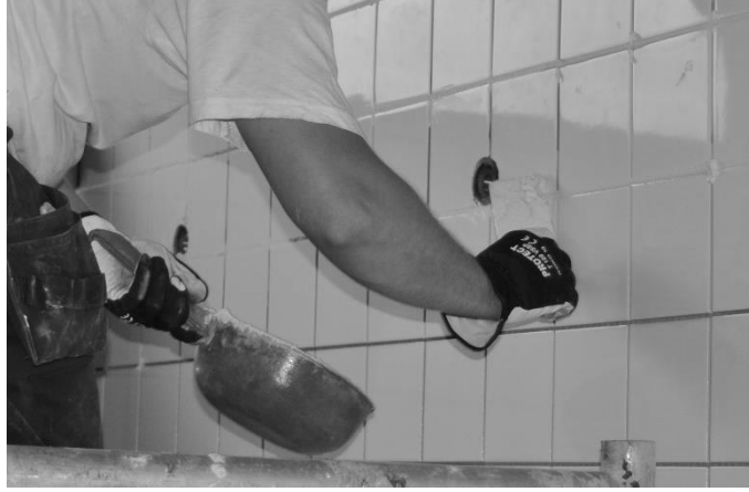
Kuva 15. Laattojen saumauksen tasaamista.
