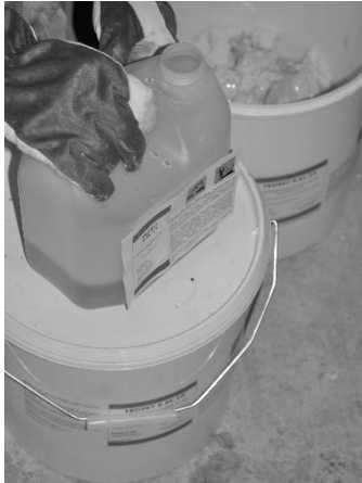
Kuva 14. Saumauspinnoitteen nestemäinen epoksihartsiosa kaadettiin kanisterista suurisuisseen koveteastiaan.
